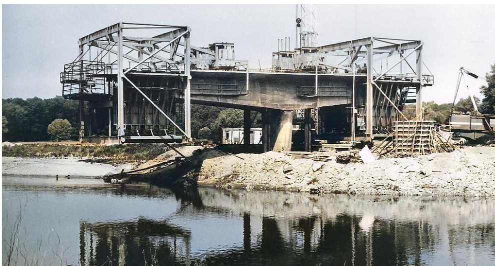
Obr. 9 Ťažké betonážne vozíky s protizávažím nasadené pri výstavbe mosta rámci diaľnice D2 ponad rieku Moravu, 1979, kolorizované (foto: Ing. G. Tevec).
