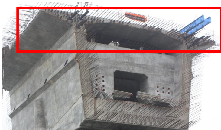
Obr. 62 Pohľad na konzolové káble a predpripravené káblové kanáliky pre konzolové káble (zárodok Lužného mosta v Bratislave, 2019)
