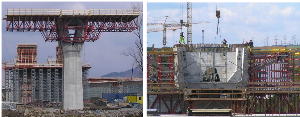
Obr. 84 Výstavba zárodku so skružou uchytenou priamo na pilier. Výstavba prebiehala v dvoch fázach – spodná doska, trámy a následne horná doska. Most v Považskej Bystrici, 2009.
