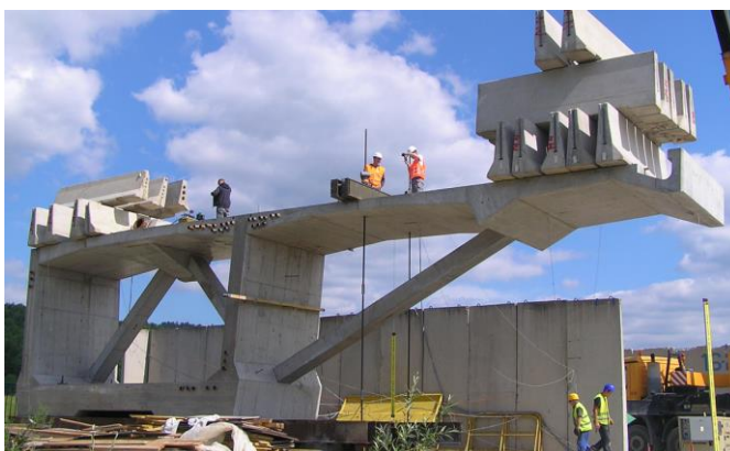
Obr. 73 Zaťažovacia skúška segmentu (most v Považskej Bystrici, 2009)
