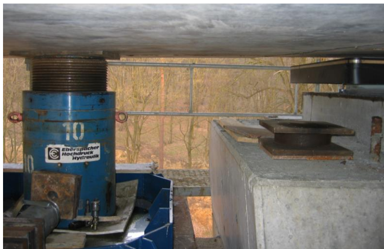
Obr. 89 Zárodok uložený na zaaretovaných hydraulických lisoch.
