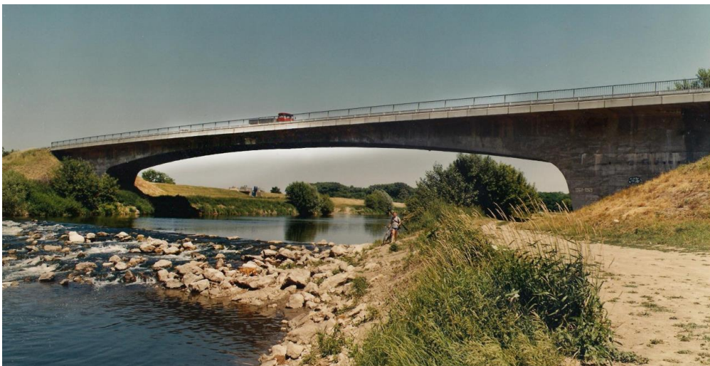
Obr. 18 Most pri Komoči (foto Ing. G. Tevec)
