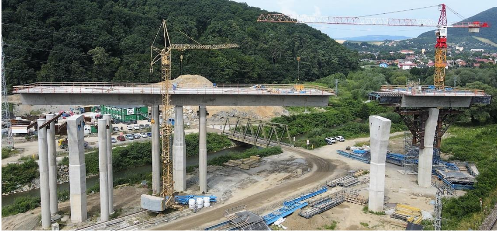
Obr. 115 Stabilizácia vahadla betónovými dočasnými piliermi (vľavo) a oceľovou konštrukciou uchytenou o pilier (vpravo), výstavba diaľnice D1 na obchvate Prešova, 2021.
