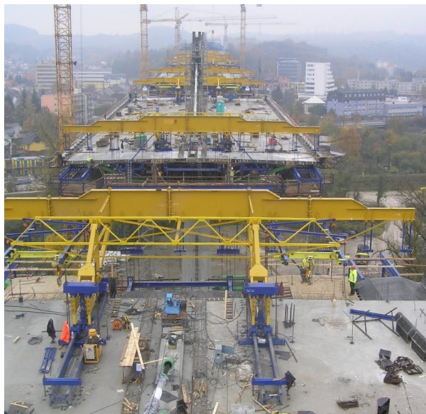
Obr. 102 Nasadenie betonážnych vozíkov na všetky vahadlá naraz – celkovo 14 ks. (Most v Považskej Bystrici, 2009).
