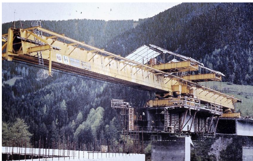
Obr. 110 Výstavba letmou betonážou s využitím podporného trámu (fotka z prednášok doc. Zvaru, diapozitív z roku cca 1990).
