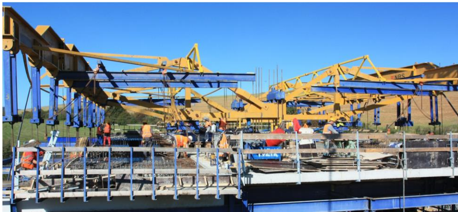
Obr. 87 Osadenie betonážnych vozíkov na zárodok vzájomne prepojených v mieste kotvenia (fast split assembly), most v rámci úseku D1: Fričovce – Svinia, 2014.
