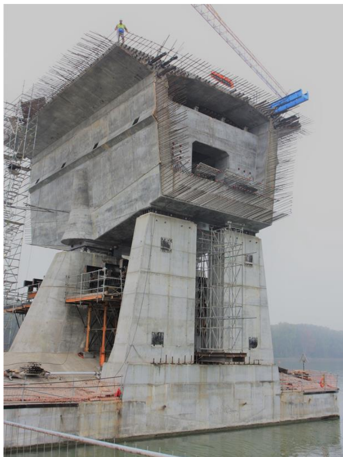
Obr. 88 Zárodok Lužného mosta s jednostrannou, asymetrickou, stabilizáciou vahadla dočasným pilierom, 2019.
