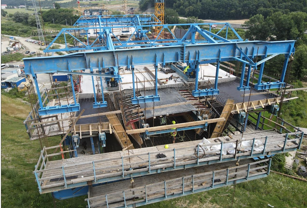
Obr. 96 Pohľad na obslužné lávky betonážneho vozíka nasadeného pri výstavbe mostov na stavbe diaľnice D1 na obchvate Prešova, 2021.
