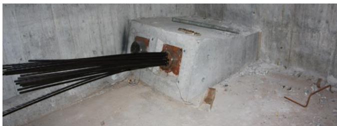
Obr. 66 Kotvenie káblov spojitosti v náliatku spodnej dosky
