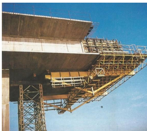
Obr. 104 Betonážny vozík so spodnou rámovou konštrukciou (prípojná estakáda mosta Lafranconi v Bratislave, 1990)
