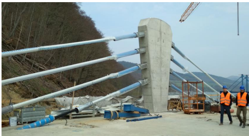
Obr. 70 Pohľad na pylón s osadenými káblami typu extradossed (most cez Nosickú priehradu, 2019)
