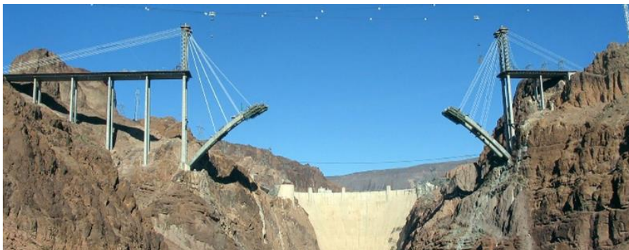
Obr. 45 Letmá betonáž pri stavbe oblúkových mostov [21]
