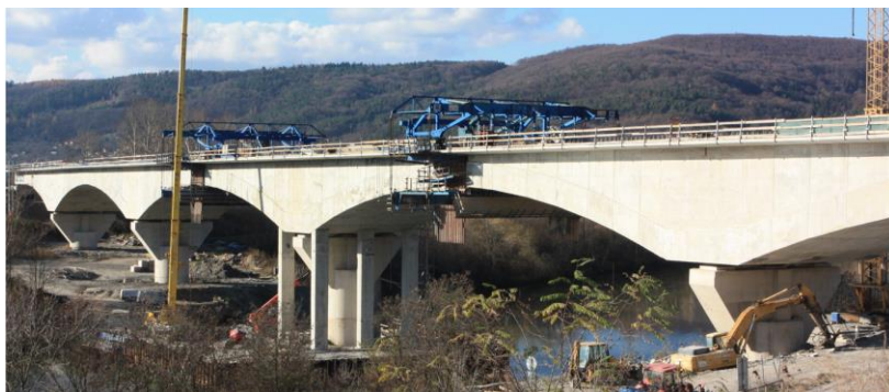
Obr. 34 Železničný most pri Púchove počas výstavby, 2018
