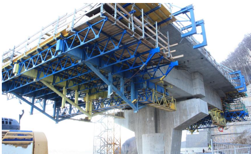
Obr. 103 Betonážny vozík so spodnou rámovou konštrukciou (železničný most cez Nosickú priehradu, 2018).
