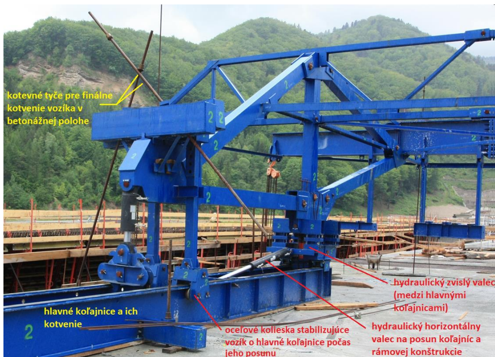
Obr. 92 Základný rám moderného betonážneho vozíka uloženého na hlavnej koľajnici kotvenej do hornej dosky hotovej lamely.
