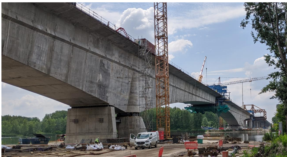
Obr. 39 Výstavba mosta ponad veslársku dráhu, 2020
