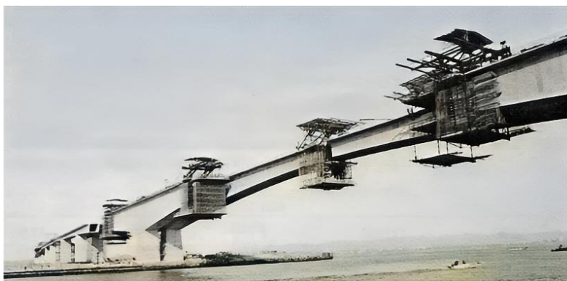
Obr. 4 Výstavba mosta Hamana v Japonsku, kolorizované [1]
