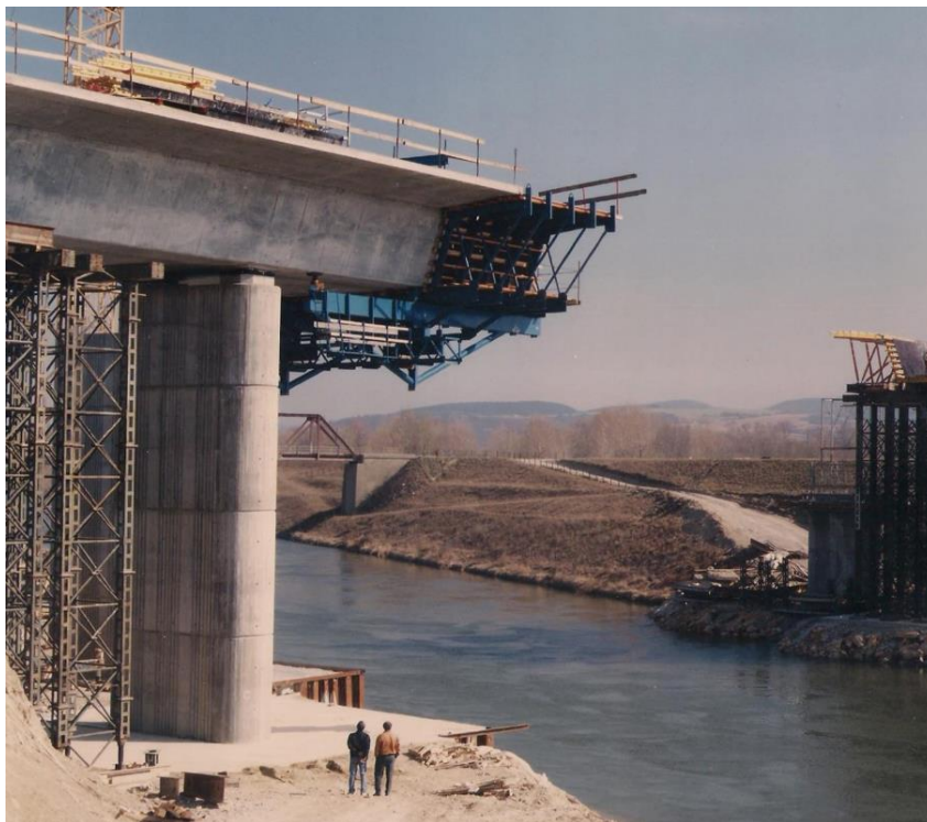
Obr. 49 Dvojetapová letmá betonáž, betonážny vozík so spodnou rámovou konštrukciou (Diaľnica D1, most cez Biskupický kanál pri Hornej Strede, 1997, foto: Ing. G. Tevec)
