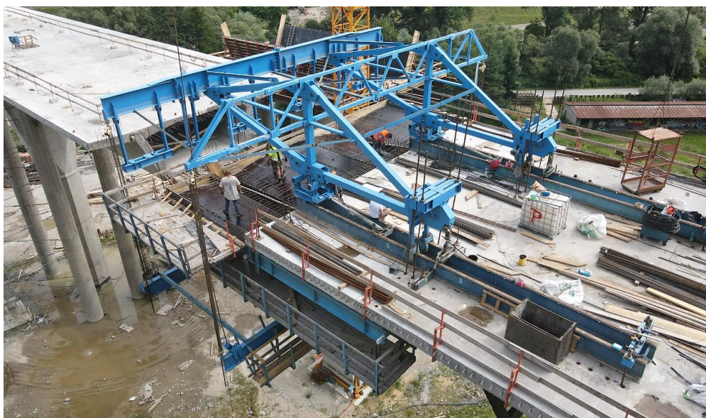
Obr. 95 Pohľad na betonážny vozík nasadený pri výstavbe mostov na stavbe diaľnice D1 na obchvate Prešova, 2021.
