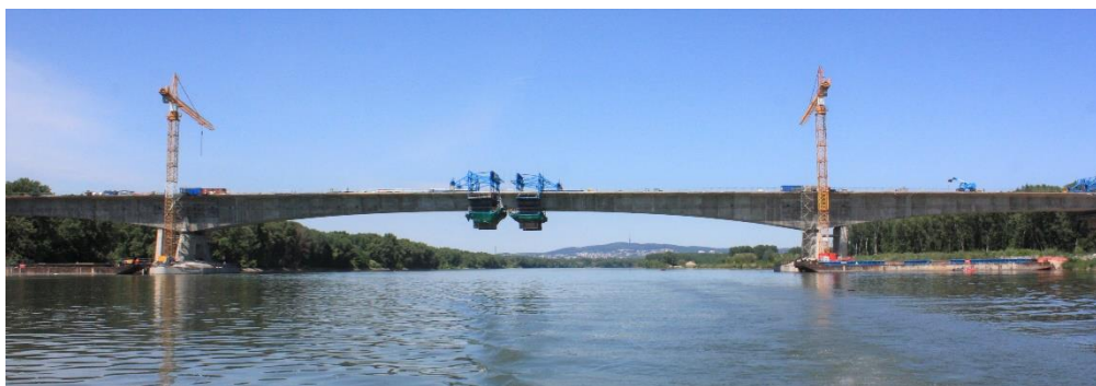
Obr. 38 Výstavba mosta ponad Dunaj, 2020
