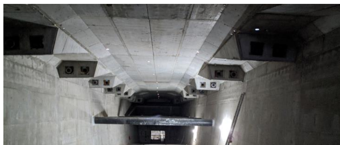
Obr. 63 Pohľad na náliatky na hornej doske komory pre kotvenie dodatočne zhotovených konzolových káblov (Lužný most v Bratislave, 2020)
