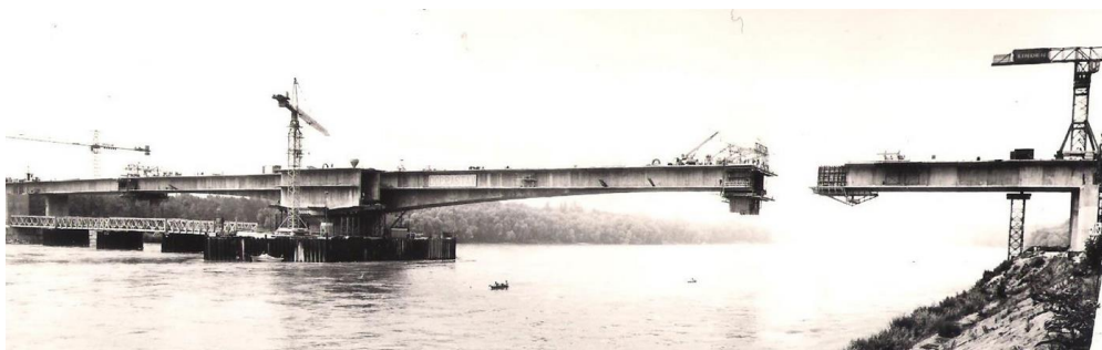
Obr. 22 Výstavba mosta Lafranconi v Bratislave, 1990 (foto: Ing. G. Tevec)
