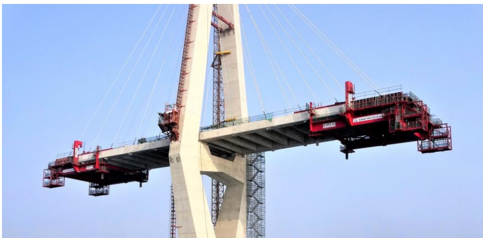
Obr. 43 Letmá betonáž pri stavbe zavesených mostov [21]
