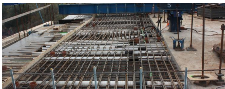
Obr. 64 Pohľad na plastové káblové kanáliky pre elektro-izolované konzolové káble (Železničný most pri Púchove ponad vodnú nádrž Nosice, 2020)
