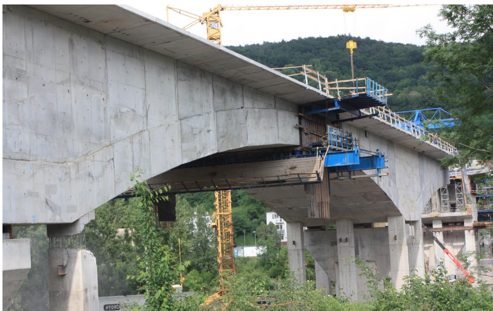
Obr. 101 Osadené debnenie pre zhotovenie poslednej lamely medzi konzolami vahadla. Vľavo vidieť prepílenú dočasnú betónovú podperu stabilizácie vahadla (železničný most cez Nosickú priehradu, 2018).
