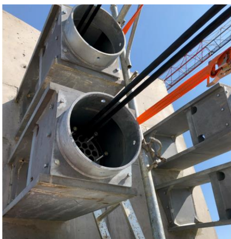
Obr. 71 Sedlo s kotvami pre káble na každej strane (most v Prešove, 2021, foto: P. Pažma)
