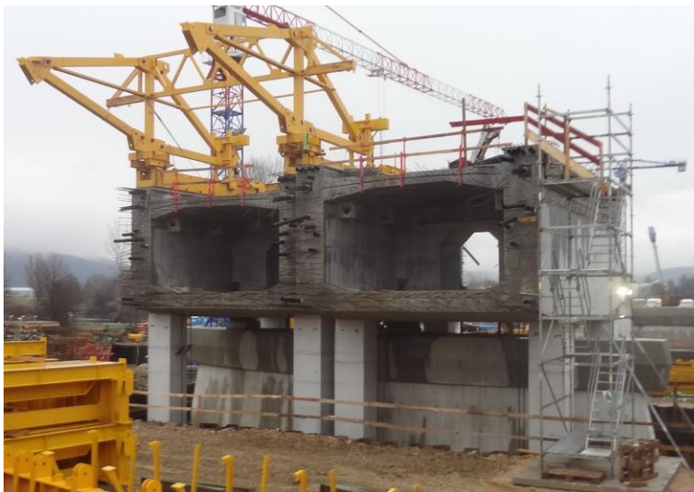
Obr. 114 Stabilizácia vahadla betónovými dočasnými piliermi opretými o zárodok vahadla (výstavba železničného mosta v Trenčíne, 2014).
