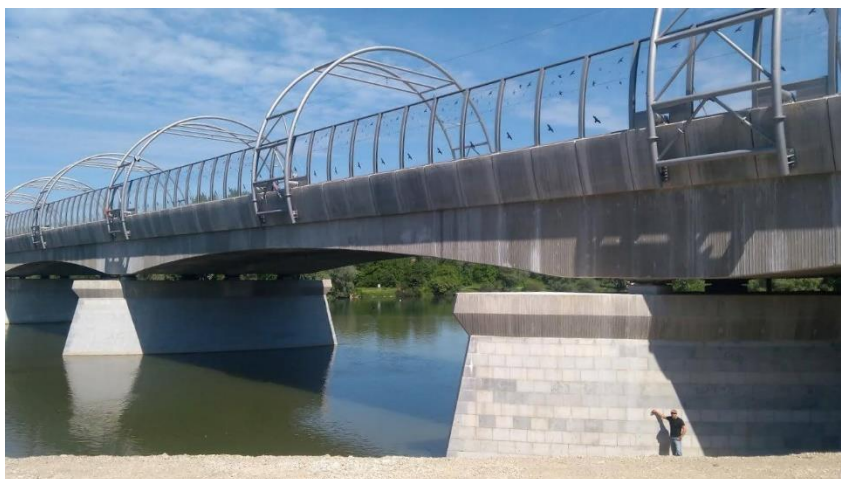
Obr. 32 Prvý železničný most stavaný technológiou letmej betonáže na Slovensku, Trenčín
