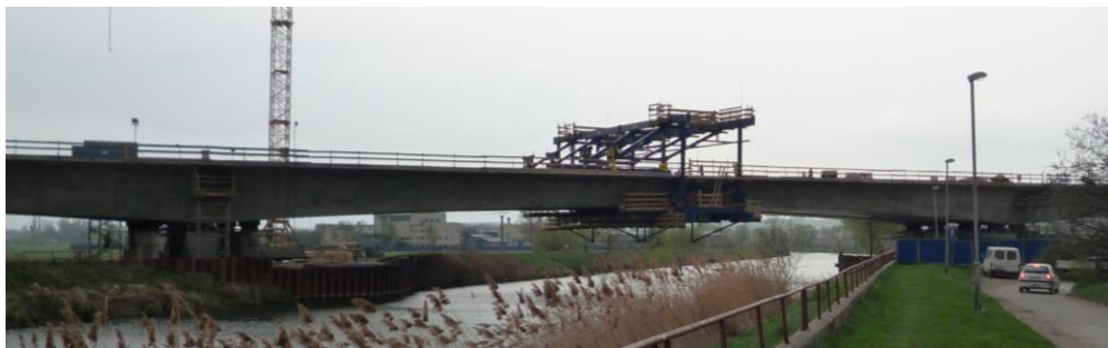
Obr. 100 Zmonolitnenie vahadiel s využitím jedného z betonážnych vozíkov.
