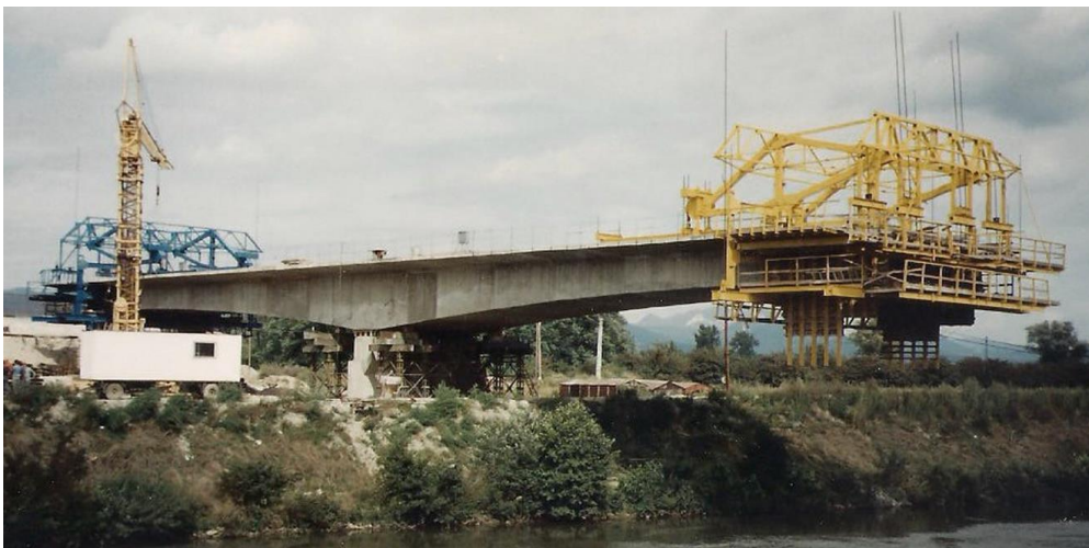
Obr. 10 Ľahké betonážne vozíky nasadené pri výstavbe mosta pri Dubnici nad Váhom v roku 1995 (foto: Ing. G. Tevec).
