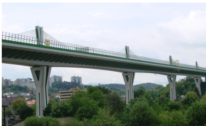
Obr. 26 Most v Považskej Bystrici (foto: Ing. M. Maťaščík)
