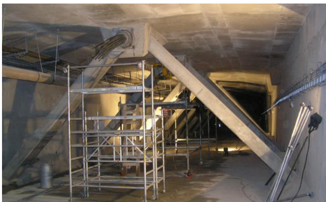
Obr. 72 Kotvenie káblov typu extradossed v komore mosta a pohľad na predopnuté šikmé ťahadlá prenášajúce silu z kotveného do stien komory mosta (most v Považskej Bystrici, 2010)
