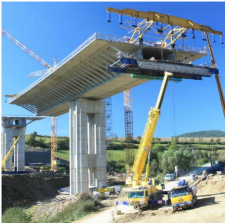
Obr. 116 Stabilizácia vahadla dočasným kotvením o piliere (most v rámci úseku D1: Fričovce – Svinia, 2014.)
