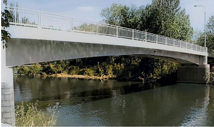
Obr. 7 Most na Veslářský ostrov v Praze 1. letmo betónovaný most na území bývalého Československa (1958).
