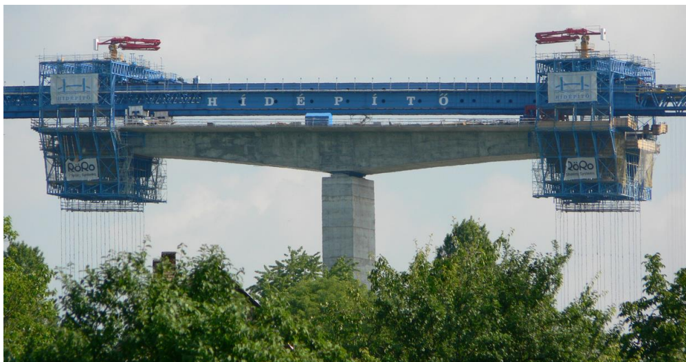
Obr. 109 Výstavba letmou betonážou s využitím podporného trámu (most Kőröshegy v Maďarsku, 2005) [22].
