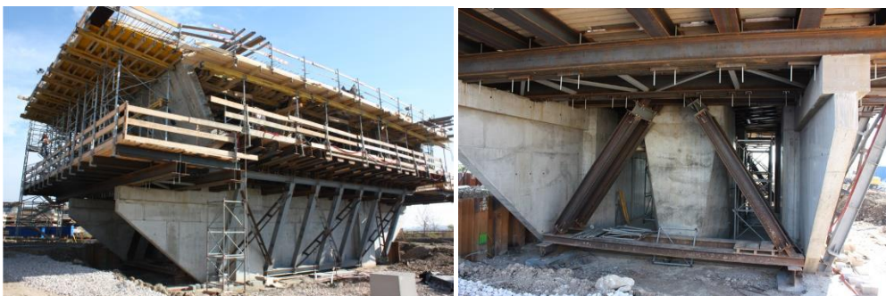
Obr. 83 Výstavba zárodku so skružou položenou na základ a dočasné piliere stabilizácie vahadla. Most v Nitre, 2010.
