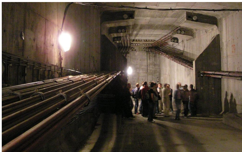
Obr. 68 Voľne vedené káble prechádzajúce cez deviátor (most Lafranconi)
