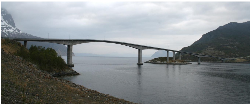
Obr. 5 Most Stolma v Nórsku s rekordným rozpätím pre letmú betonáž 301 m [4]
