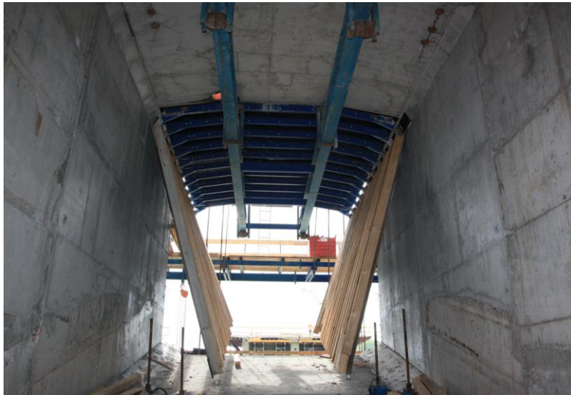
Obr. 99 Pohľad na tunelové debnenie vnútra komory (železničný most cez Nosickú priehradu, 2017).
