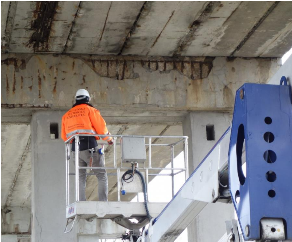
Podrobná prehliadka mosta. Bojnická ulica v Bratislave.
