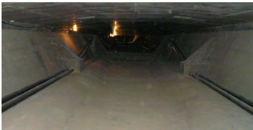
Obr. 27: Pohľad na polygonálne externé káble v komore vysúvaného mosta pri Štrbe
