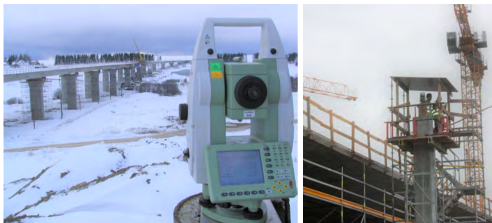
Obr. 91: Geodetické sledovanie mosta počas vysúvania. Vľavo: stanovisko na vyvýšenom teréne, vpravo: stanovisko na dočasnom stĺpe v prípade rovinatého terénu.
