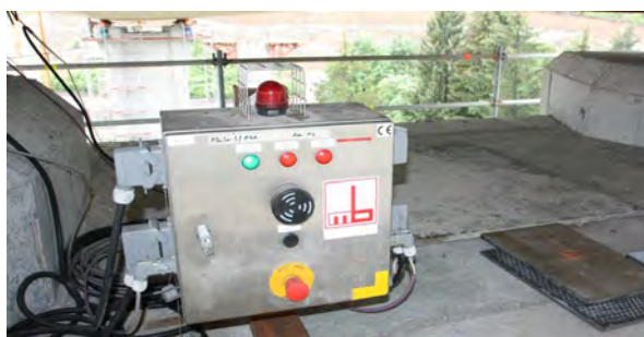
Obr. 89: Signalizácia výsunu a STOP tlačidlo pre vypnutie výsunu v prípade neočakávanej udalosti
