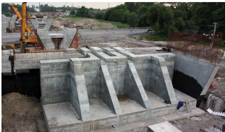
Obr. 41: Opora s výstužnými rebrami – Poľsko
