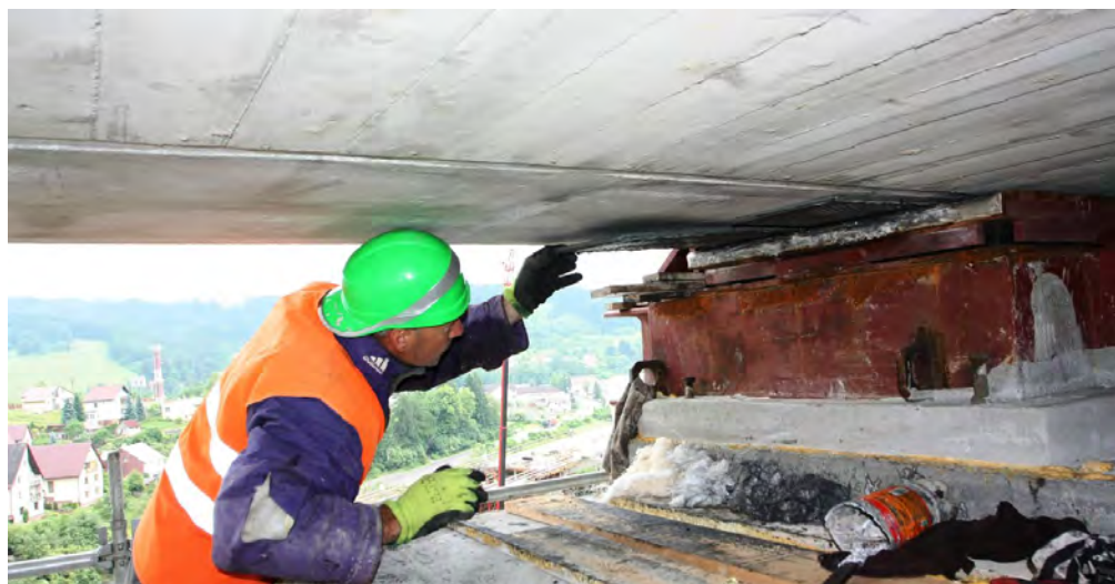
Obr. 81: Vkladanie teflónovej platne medzi klzné ložisko a konštrukciu mosta. Most pri Svrčinovci
