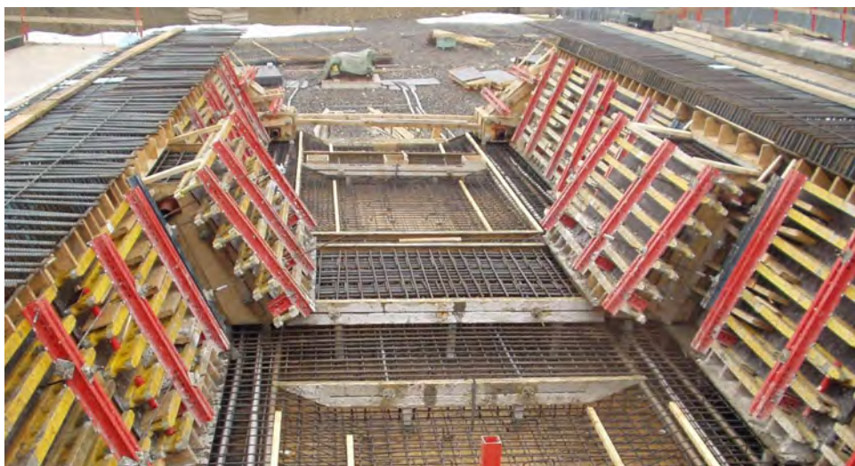
Obr. 22: Debnenie stien komory a priečnika vysúvaného mosta pri Štrbe. Priečník nebol spojený s hornou doskou a mal minimálne rozmery. V pozadí vidieť aj debnenie deviátorov pre externé predpínacie káble.
