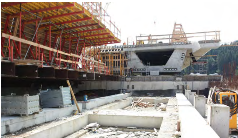
Obr. 69: Výrobňa priečne (šíkmo) presunutá do novej polohy. Most vo Svrčinovci.
