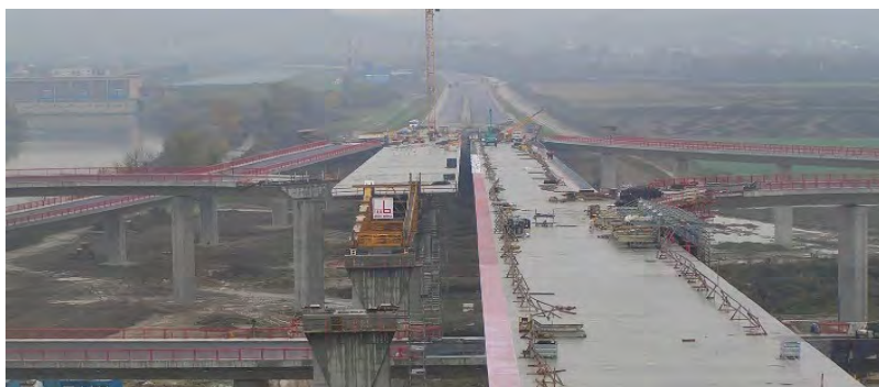
Obr. 6: Výstavba vysúvaného mosta v Považskej Bystrici
