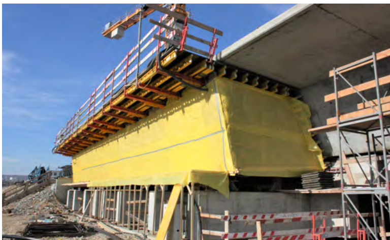
Obr. 68: Vyhrievaná výrobňa. Most v Nitre.
