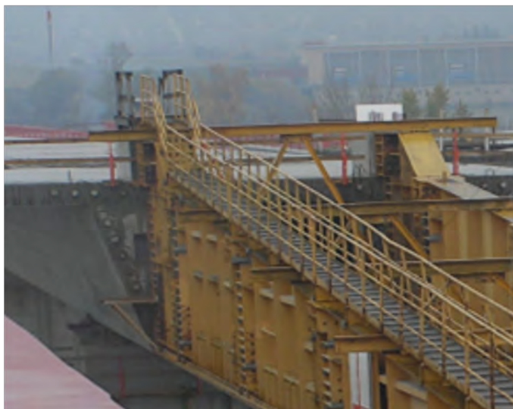
Obr. 47: Napojenie výsuvného nosa na most – šikmé steny komory. Most v Považskej Bystrici
