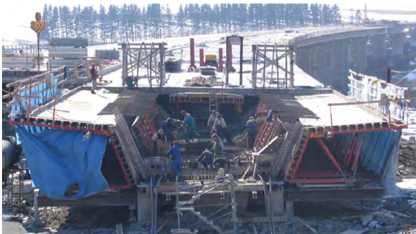
Obr. 59: Vystužovanie a debnenie spodnej dosky, trávov deviátorov a priečnika.
