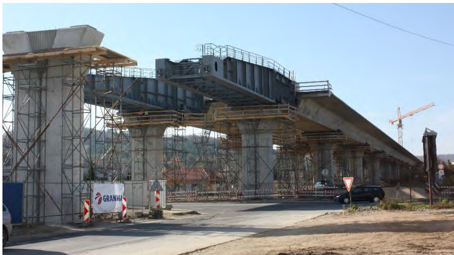
Obr. 8: Vysúvaný most v Nitre – pohľad na výsuvné nosy
