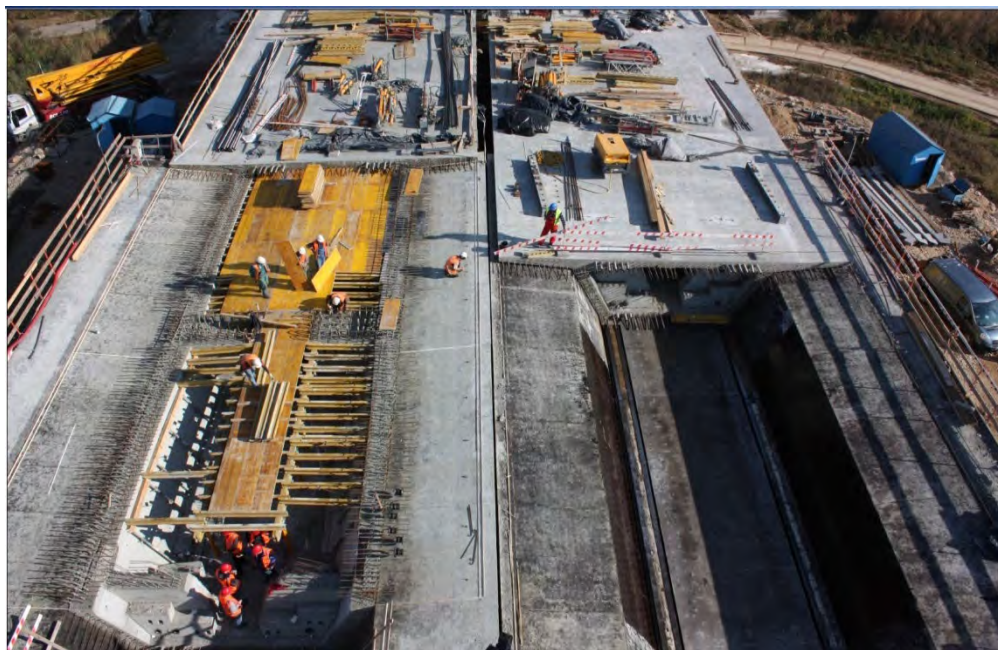
Obr. 77: Dve výroby pri výstavbe dvoch paralelných mostov súčasne. Vpravo je vidieť most počas vysúvania – keďže predpínacie káble sú prekotvované v rámci priečnika (neštandardné riešenie), nie sú pri výsune mosta ešte osadené. Vysúvaný most v Nitre.
