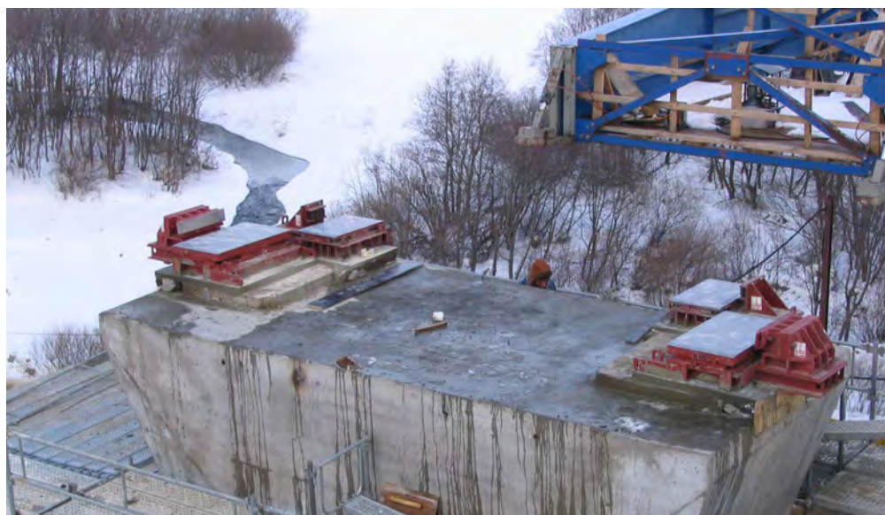
Obr. 84: Kľzné ložiská pre výsuvný nos a pre konštrukciu mosta. Most pri Štrbe.
