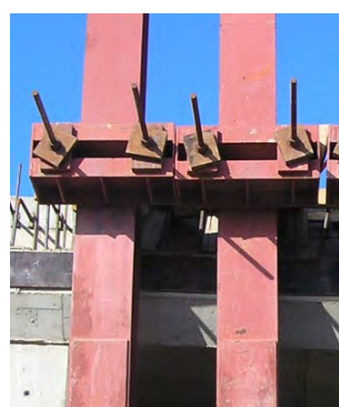
Obr. 55: Umiestnenie oceľových nosníkov pri výsune posledného segmentu (vpravo – detail pripojenia v hornej časti závitovými vysokopevnostnými tyčami) – most v Štrbe.
