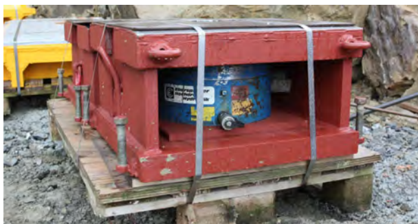
Obr. 71: Hydraulicky výškovo nastaviteľné klzné ložisko
