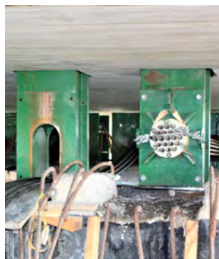
Obr. 54: Oceľové ťažné laná kotvené cez odnímateľnú hlavicu do oceľového nosníka prechádzajúceho cez vynechané otvory v spodnej a hornej doske komory mosta
