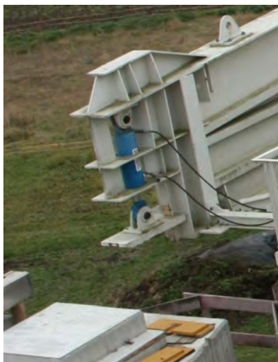
Obr. 49: Kyvná “klapka” (vľavo) a zvislý lis (vpravo) slúžiace na “našľapovanie” výsuvného nosa na klzné ložiská.
