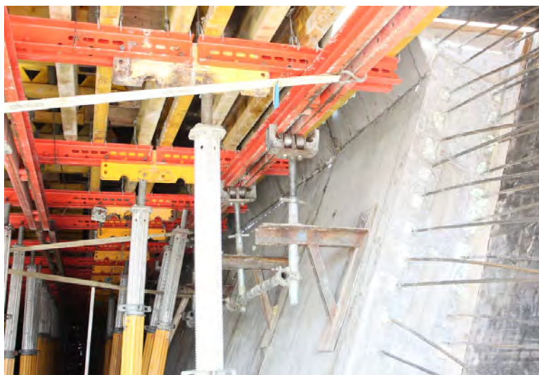
Obr. 64: Krátke podperné konzoly osadené na steny komory pre urýchlenie presunu debnenia hornej dosky do ďalšieho záberu. Vysúvaný most pri Ružomberku.
