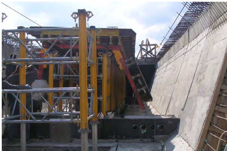
Obr. 63: Presun debnenia hornej dosky so sklopenými konzolami debnenia. Most v Považskej Bystrici
