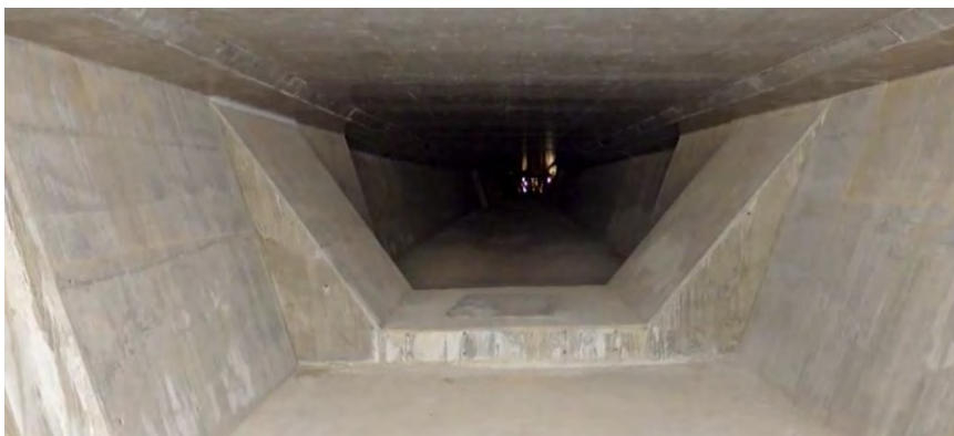
Obr. 21: Priechnik vysúvaného mosta pri Svrčinovci
