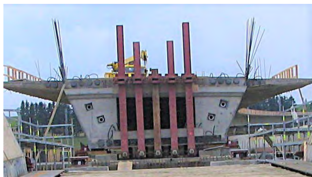
Obr. 55: Umiestnenie oceľových nosníkov pri výsune posledného segmentu (vpravo – detail pripojenia v hornej časti závitovými vysokopevnostnými tyčami) – most v Štrbe.
