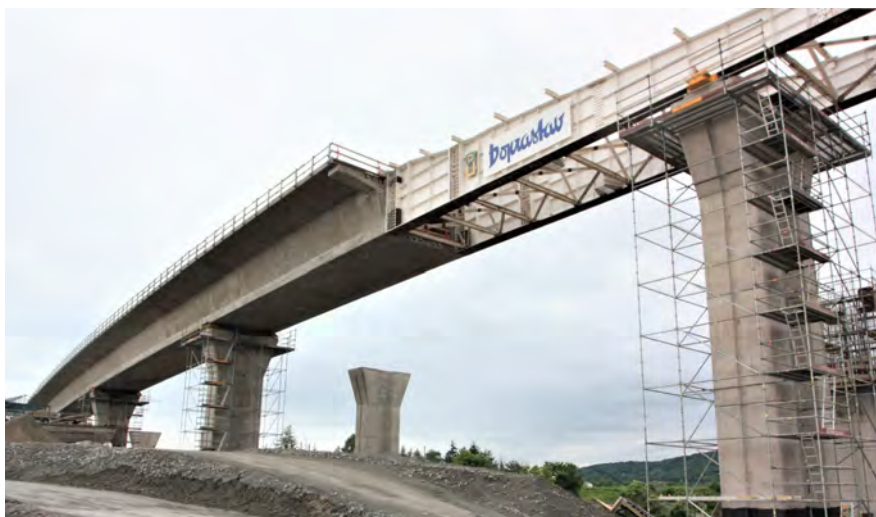
Obr. 14: Vysúvaný most pri Prešove počas výstavby, 2019
