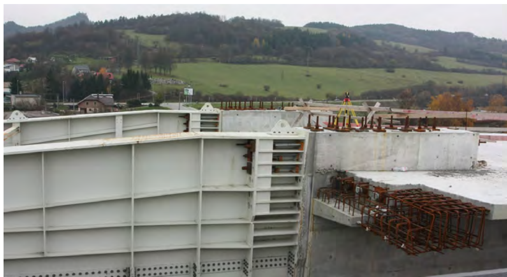
Obr. 45: Napojenie výsuvného nosa na most (riešenie pre prípad kedy je výška ocelevej konštrukcie vyššia ako výška betónového prierezu mosta) – most pri Žiline.
