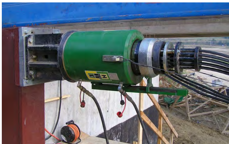
Obr. 52: Hydraulický ťažný lis
