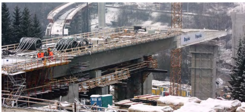
Obr. 13: Pohľad na vysúvaný most vo Svrčínovci počas výstavby
