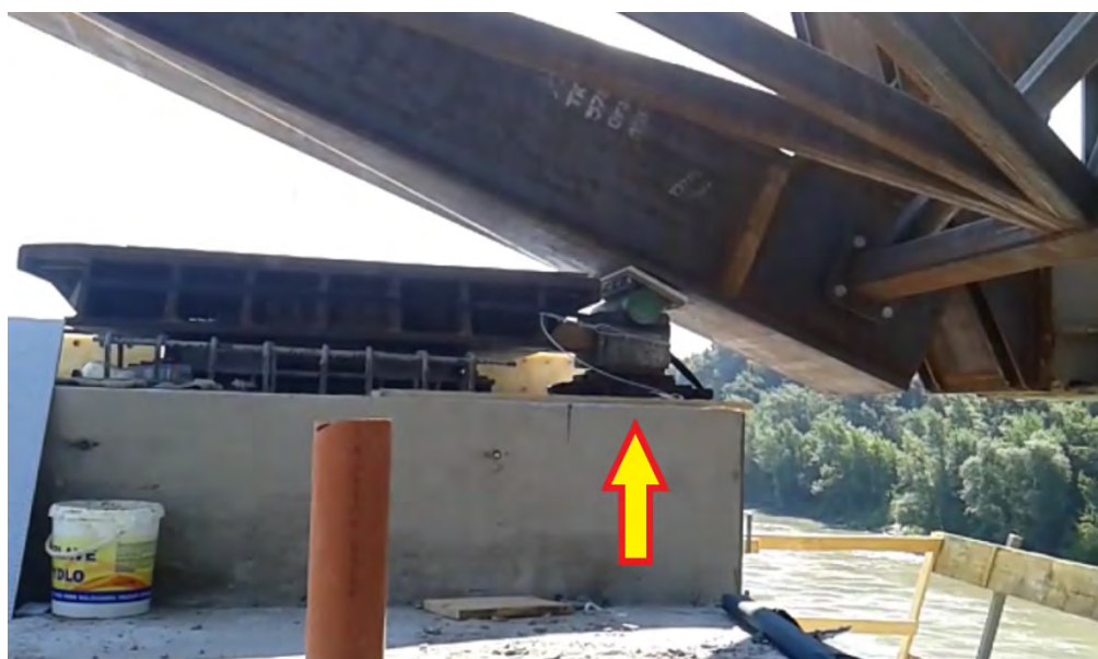
Obr. 50: Pomocné klzné ložisko s veľkou rotačnou kapacitou pre “našľapovanie” pomocou kyvnéj “klapky” pri veľkých deformáciách konzoly (prestavba Starého mosta v Bratislave).
