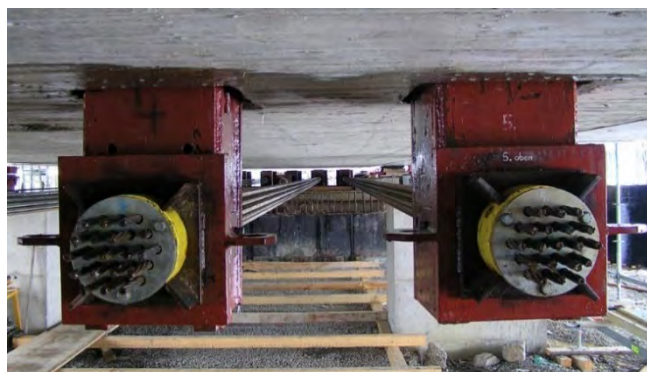
Obr. 54: Oceľové ťažné laná kotvené cez odnímateľnú hlavicu do oceľového nosníka prechádzajúceho cez vynechané otvory v spodnej a hornej doske komory mosta
