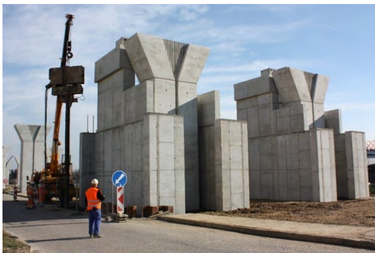
Obr. 9: Dočasné masívne podpery pri pilieroch, na ktoré sa umiestnili druhé páry výsuvných zariadení (prvé páry bol na opore)
