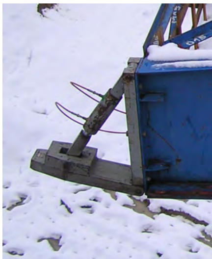
Obr. 49: Kyvná “klapka” (vľavo) a zvislý lis (vpravo) slúžiace na “našľapovanie” výsuvného nosa na klzné ložiská.
