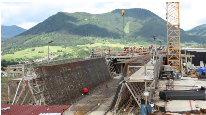
Obr. 66: Príprava armokošov na stavenisku v špeciálnej drevenej forme s kontúrami zodpovedajúcimi debneniu výrobné . Vysúvaný most pri Ružomberku.
