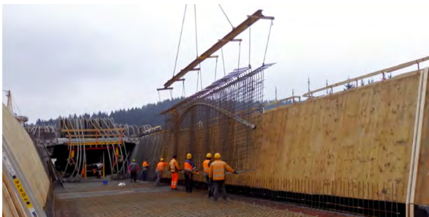
Obr. 67: Osadzovanie armokoša do debnenia už s osadenými káblovými kanálikmi pre polygonálne predpínacie káble, ktoré budú aktivované až po vysunutí celého mosta.
