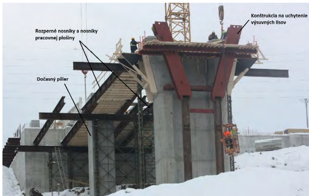
Obr. 70: Pomocné konštrukcie pre umiestnenie výsuvných lisov na pilier z dôvodu nedostatočného priestoru za oporou (výrobňa musela byť umiestnená tesne za oporou). Most pri Svrčinovci.
