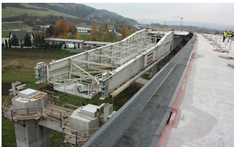
Obr. 11: Vysúvaný most pri Žiline
