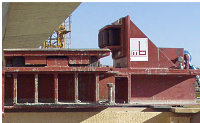
Obr. 79: Štandardné klzné ložisko s osadeným bočným vedením pre výsuvný nos
