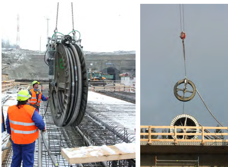
Obr. 65: Ukladanie predpínacích káblov do debnenia. Most pri Svrčinovci.
