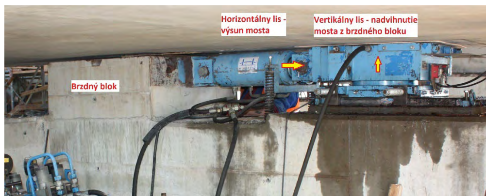
Obr. 56: Sústava lisov nasadená pri výstavbe mostov (hore: most pri Svrčinovci, atypické uloženie lisov na pilieri, dole: most v Nitre, štandardné usporiadanie lisov na opore)
