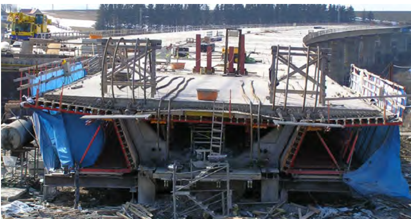
Obr. 61: Most tesne pred vysúvaním segmentu z výroby – predpínacie laná, ktoré sú priebežné cez pracovnú škáru sú vyložené na mostovke
