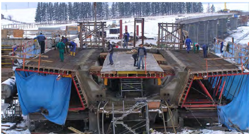
Obr. 60: Vystužovanie a debnenie hornej dosky
