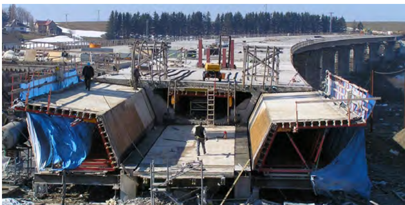
Obr. 62: Most po vysunutí segmentu z výroby
