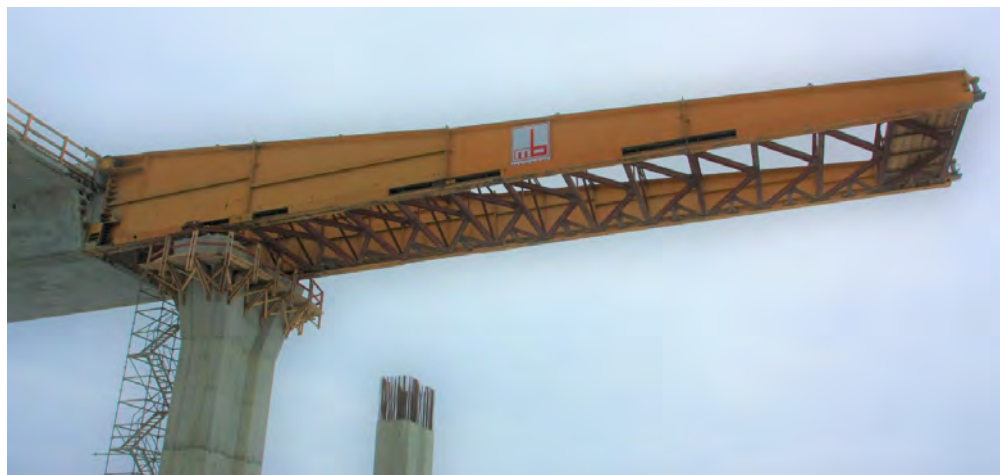
Obr. 42: Výsuvný nos - výstavba mosta pri Levoči
