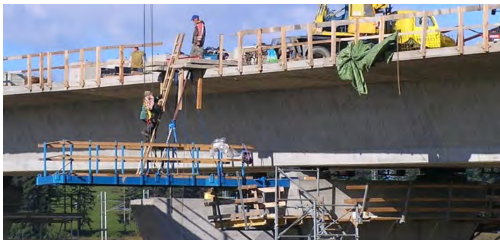
Obr. 88: Podvesená lávka slúžiaca na presun ložísk a lisov na hlavicu piliera počas výmeny ložísk
