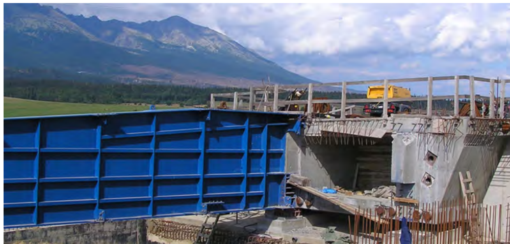
Obr. 48: Demontáž výsuvného nosa. Na obrázku vpravo je vidieť šmykovú zádržku - betónový blok, ktorý slúžil na prenos šmykových síl v mieste napojenia nosníka výsuvného nosa na koncový priečnik. Vysúvaný most pri Štrbe.
