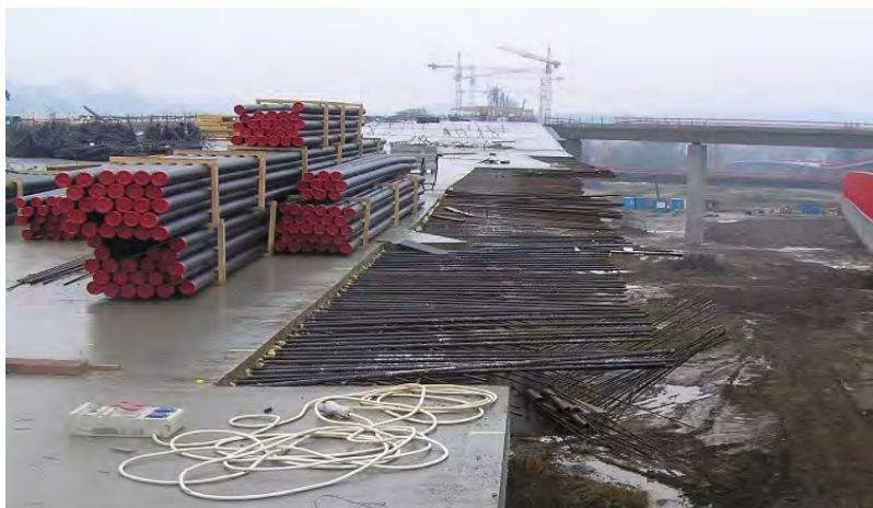
Obr. 7: Miesto napojenia odbočnej vetvy po vysunutí mosta
