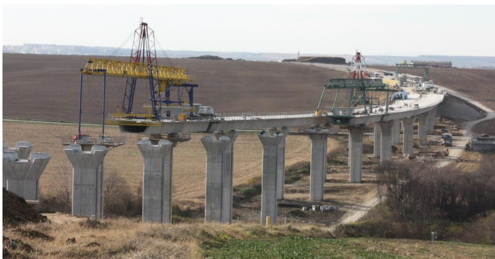
Obr. 18 Výstavba mosta na úseku R2 Selenec – Beladice, 2010.
