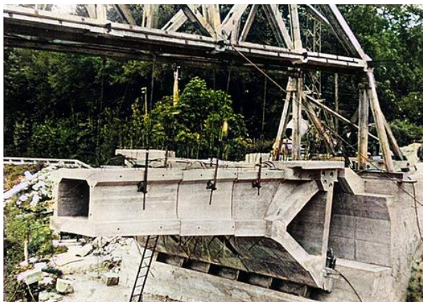
Obr. 1 Prvý letmo-montovaný most sveta, kolorizované, 1946 [5].
