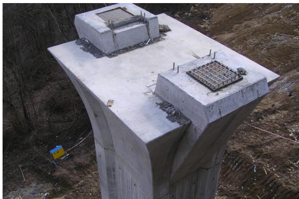
Obr. 65 Úprava hlavy piliera vytvárajúca dostatok miesta pri presune montážneho žeriava a na osadenie dočasných lisov pre podopretie a stabilizáciu vahadla (na obrázku tiež vidieť kotevné, zabetónované predpínacie tyče pre pripnutie priečnika – 4 ks pri každom náliatku).
