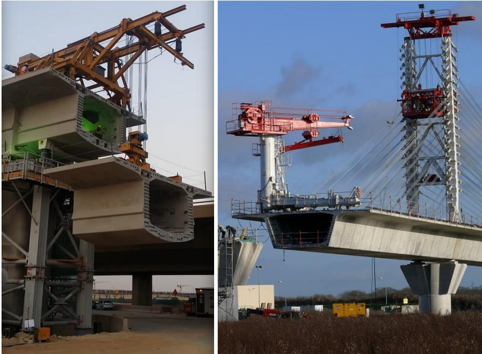
Obr. 67 Fixný (vľavo) a otočný (vpravo) zdvíhací rám (ScS).
