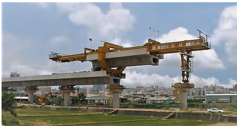
Obr. 34 Montáž s využitím makrosegmentov na dĺžku celého mostného poľa - montážny žeriav slúžiaci len na ukladanie makrosegmentov (ScS, Čína).
