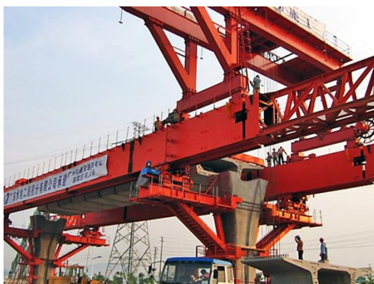
Obr. 32 Montáž s pomocou montážneho žeriava s podpretím segmentov (ScS, Čína).
