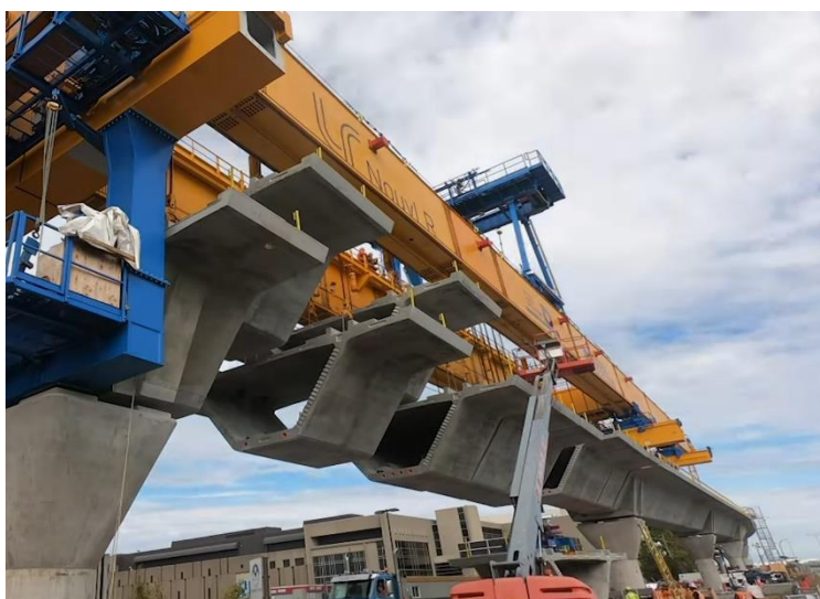
Obr. 86 Podvesené segmenty na montážnej súprave (ScS, Kanada)
