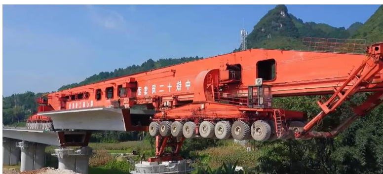
Obr. 36 Montáž s využitím makrosegmentov na dĺžku celého mostného poľa - montážny žeriav slúžiaci súčasne na dovoz a aj na uloženie makrosegmentov (ScS, Čína).
