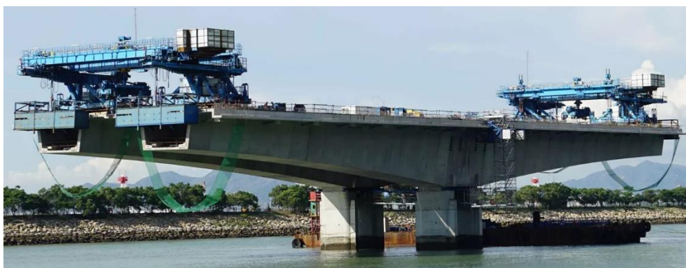
Obr. 4 Most s najväčším rozpätím na svete stavaný technológiou letmej montáže (ScS).
