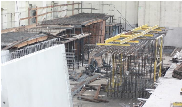
Obr. 58 Pred-viazané armokoše pre segmenty (Senec, 2017).
