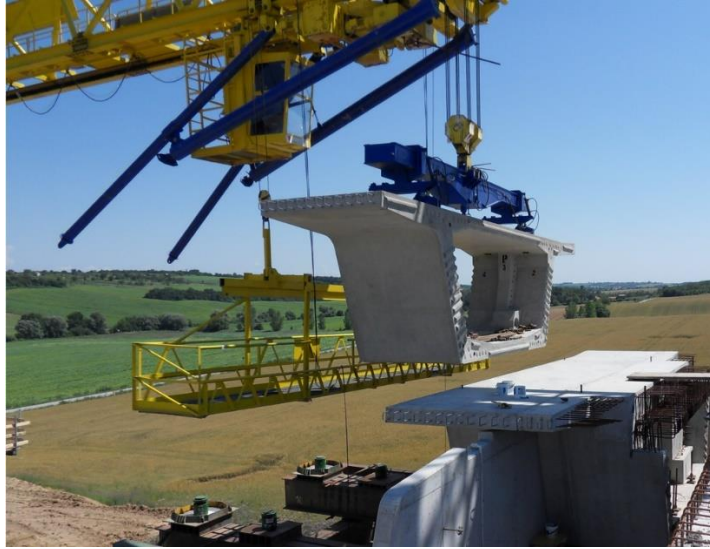
Obr. 74 Pohľad na výklopnú kabínovú podporu a osádzanie segmentu (foto: Doprastav a.s.)
