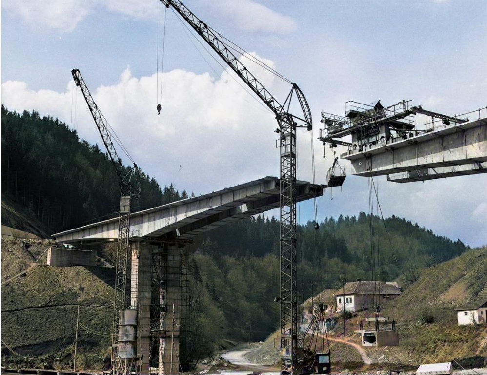
Obr. 14 Výstavba mosta pri Košických Hámroch, kolorizované, 1966 (foto: G. Bodnár, TASR).
