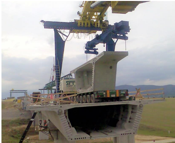
Obr. 78 Dovoz segmentu na koniec vahadla a jeho presun do montážnej polohy pomocou zdvíhacieho navijaka (Nitra, 2010, foto: Doprastav a.s.).
