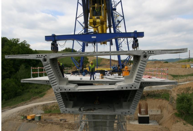
Obr. 77 Osádzanie segmentu (Považská Bystrica, 2009).
