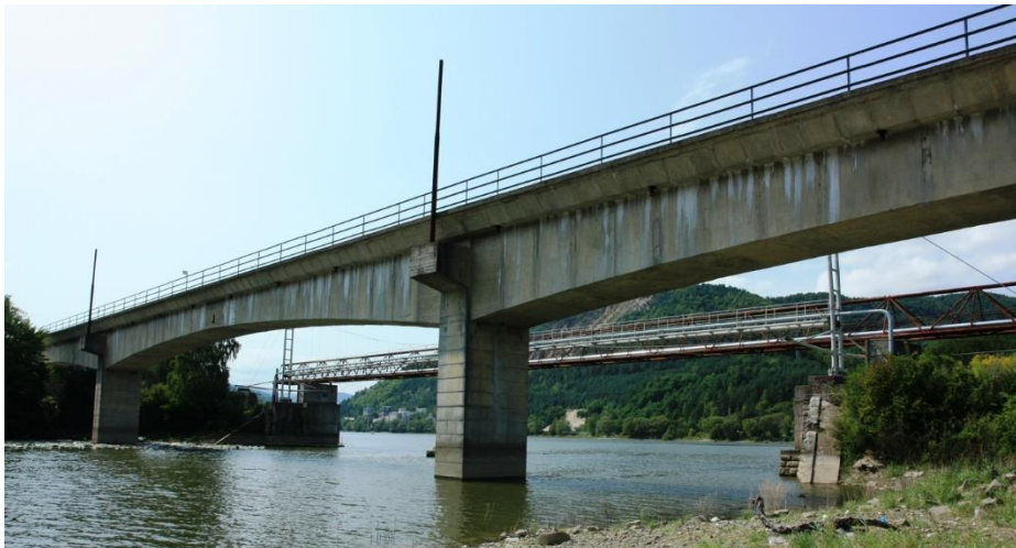
Obr. 12 Pohľad na most, 2012.
