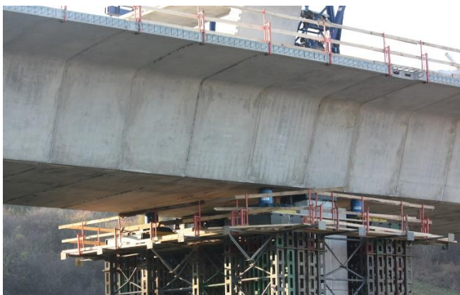
Obr. 66 Pohľad na podpernú skruž slúžiacu pre stabilizáciu vahadla.
