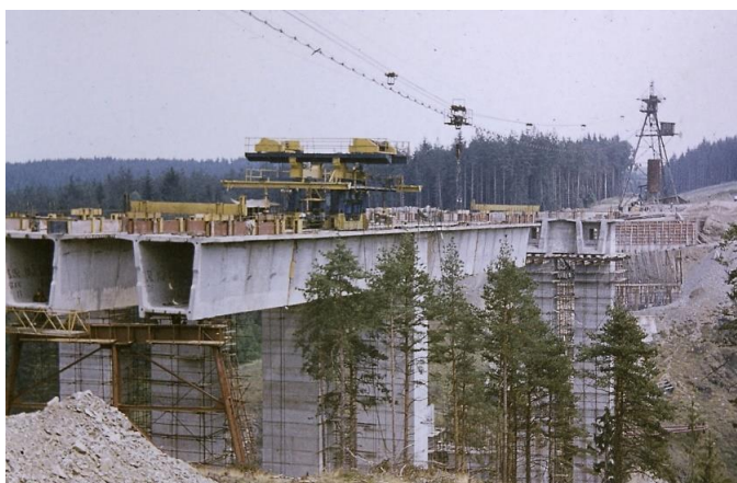
Obr. 26 Montáž zdviacím zariadením s podporou žeriava na káblovej dráhe (foto z prednášok doc. Zvaru, cca 1990).
