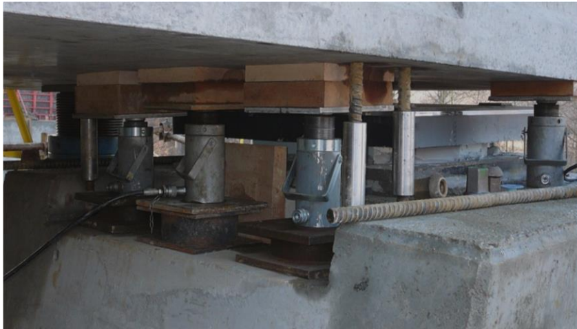
Obr. 64 Pohľad na osadený segment na pilieri aj s osadenými predpínacími tyčami (foto: Doprastav a.s.)
