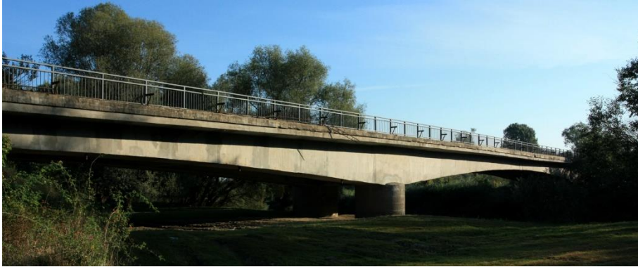
Obr. 9 Pohľad na most, 2012.
