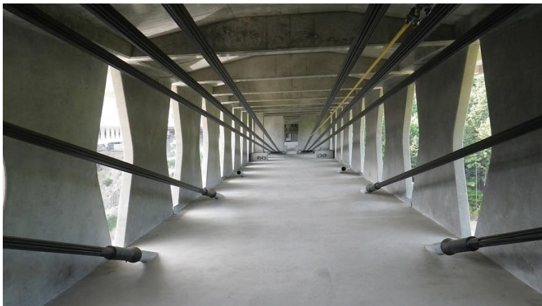
Obr. 104 Pohľad do komory mosta so stenou typu „butterfly web“ [9].
