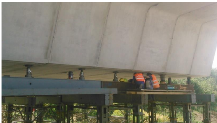
Obr. 82 Podopretie segmentov hydraulickými lismi na skruži
