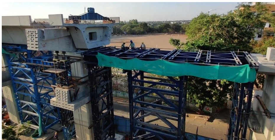
Obr. 30 Montáž na pevnej skruži (ScS, India).
