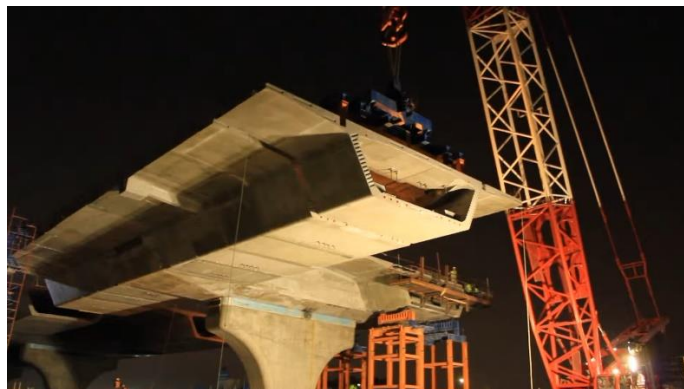
Obr. 23 Montáž žeriavom (ScS)
