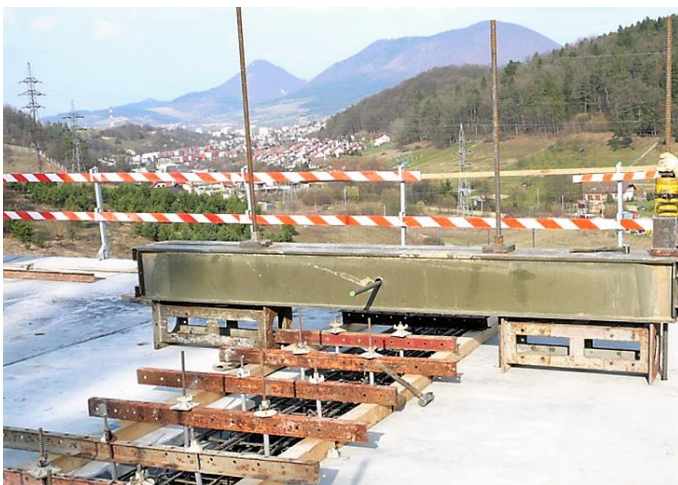
Obr. 80 Dočasná fixácia škáry pre dobetonávku medzi segmentami – foto: Doprastav a.s.
