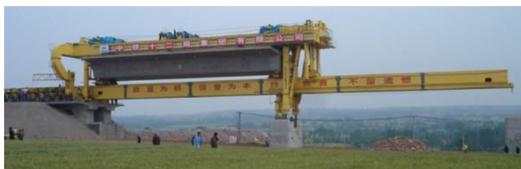
Obr. 35 Montáž s využitím makrosegmentov na dĺžku celého mostného poľa - montážny žeriav slúžiaci len na ukladanie makrosegmentov (ScS, Čína).
