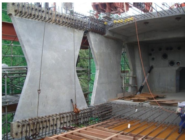
Obr. 101 Ukladanie prefabrikovanej steny do debnenia (technológia letmej betonáže) [9].
