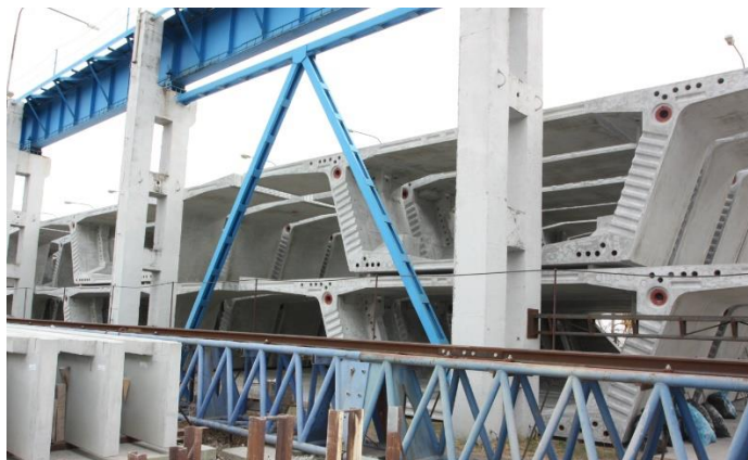
Obr. 60 Skladovanie segmentov (prefa Senec, 2017).
