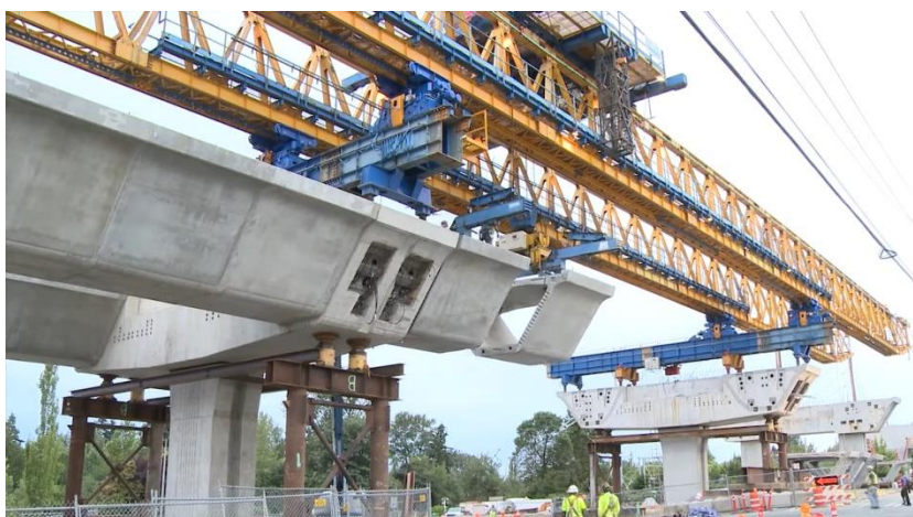
Obr. 88 Montážna súprava s priečnym presunom pre montáž paralelných mostov (priečny presun sa realizuje prostredníctvom priečnika uloženého na pilieri a už hotovej časti mostovky (ScS, USA).
