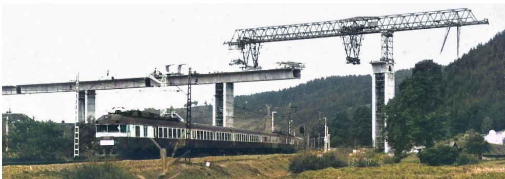
Obr. 25 Letmá montáž s využitím montážneho mosta - presun zariadenia na ďalšie vahadlo, kolorizované (most Podtureň, cca 1980, KBKM).
