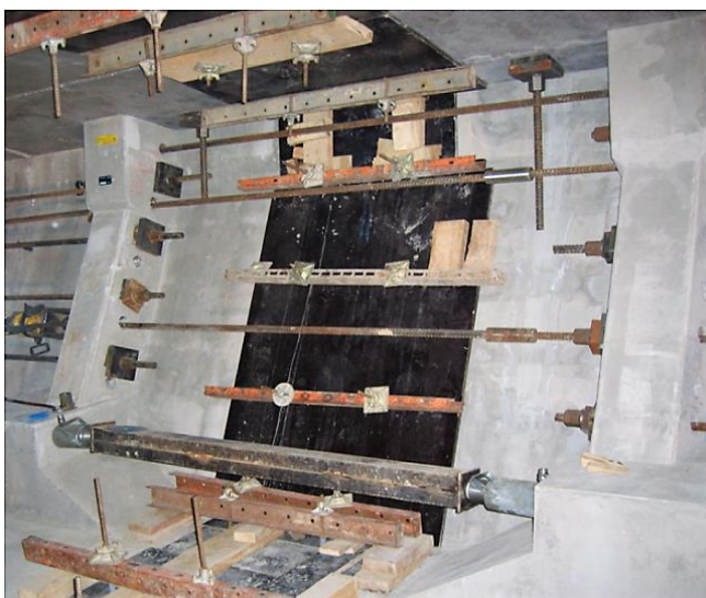
Obr. 81 Fixácia škáry – pohľad do komory mosta
