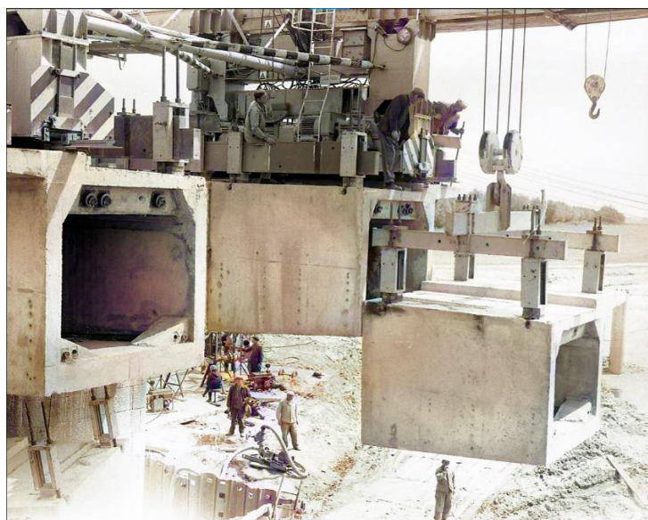
Obr. 8 Montáž segmentu v rámci mosta pri Sírniku, kolorizované, 1965 (foto: G. Bodnár, TASR).
