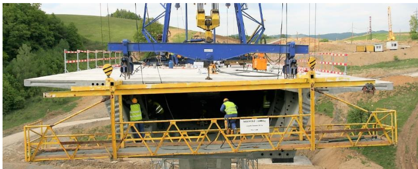
Obr. 76 Obslužná lávka pre montáž segmentov a predpínanie (Považská Bystrica, 2009).
