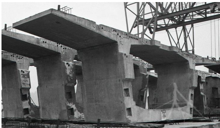
Obr. 50 Segmenty len s jedným výrazným ozubom (Podtureň, foto: TASR).
