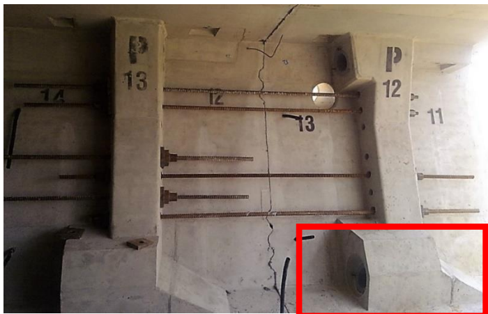
Obr. 43 Kotvenie káblov spojitosti v náliatku spodnej dosky v rámci rebra slúžiaceho k dočasnému pripnutiu segmentu k už hotovej časti konštrukcie mosta.
