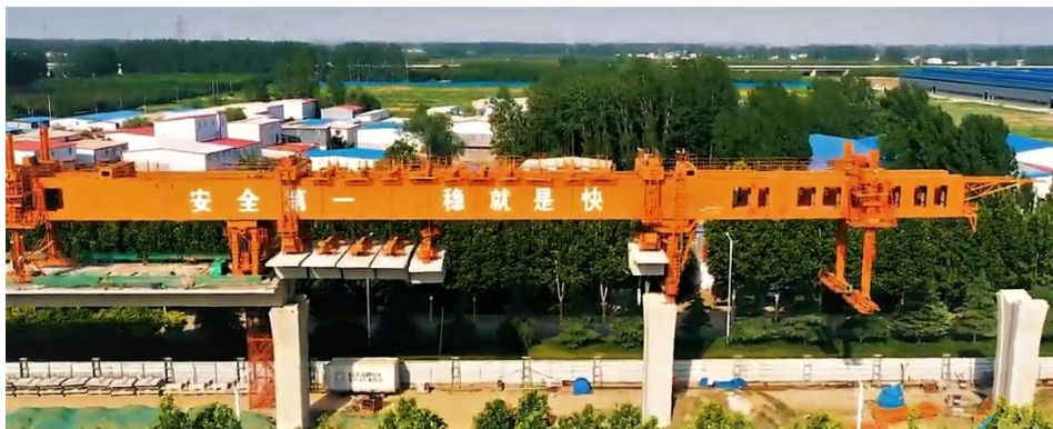
Obr. 31 Montáž s pomocou montážneho žeriava s podvesením segmentov (ScS, Čína).
