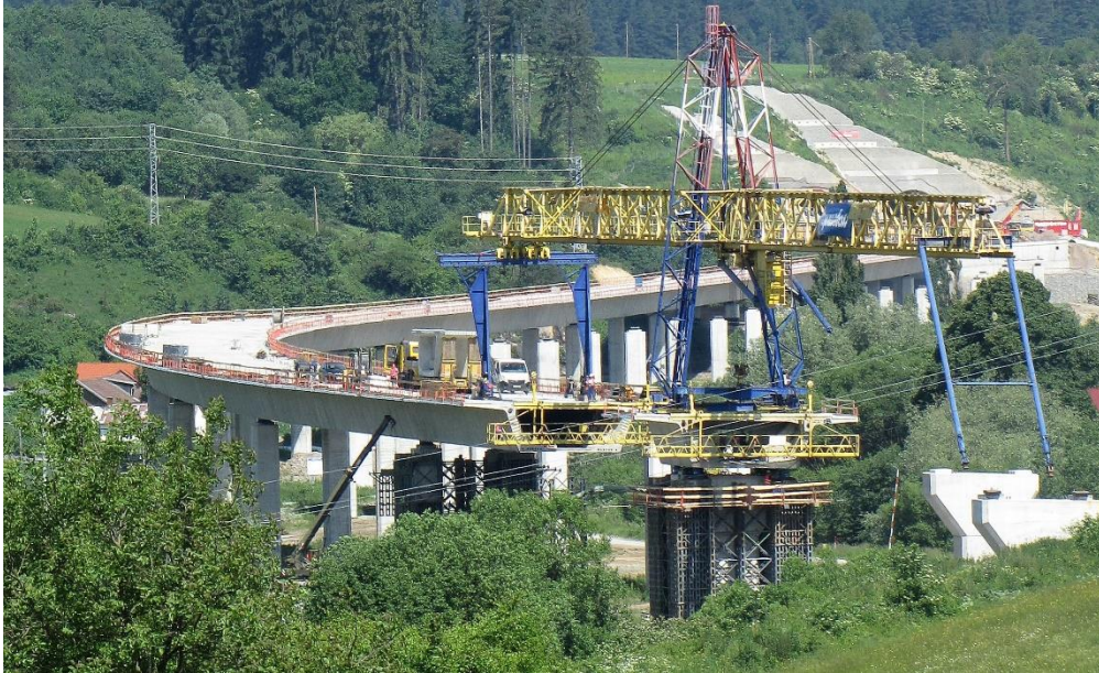
Obr. 20 Výstavba mosta na úseku D1 Hričovské Podhradie – Lietavská Lúčka, (DPS, 2016).
