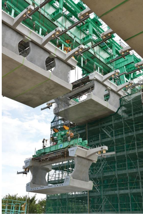
Obr. 102 Montáž prefabrikovaného segmentu so stenou typu „butterfly web“ [9].
