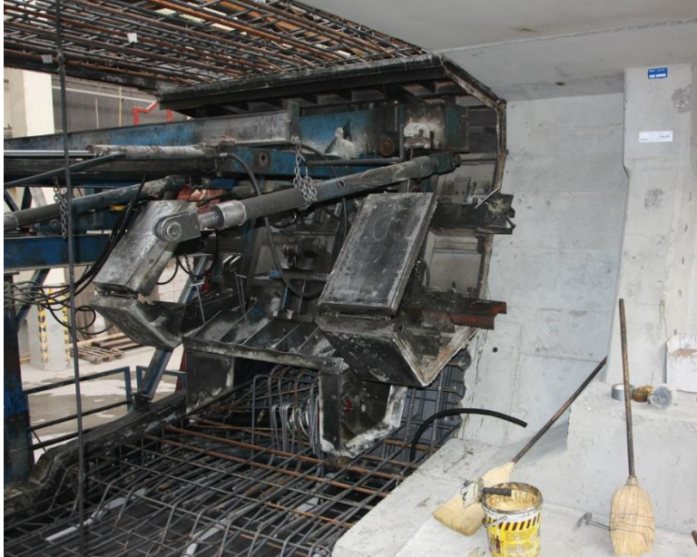
Obr. 57 Armatúra segmentu a časť vnútorného teleskopického debnenia stien (Senec, 2017).
