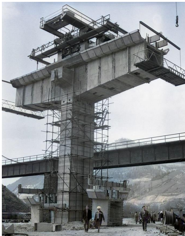
Obr. 11 Výstavba mosta pri Margecanoch, kolorizované, 1966 (foto: TASR).
