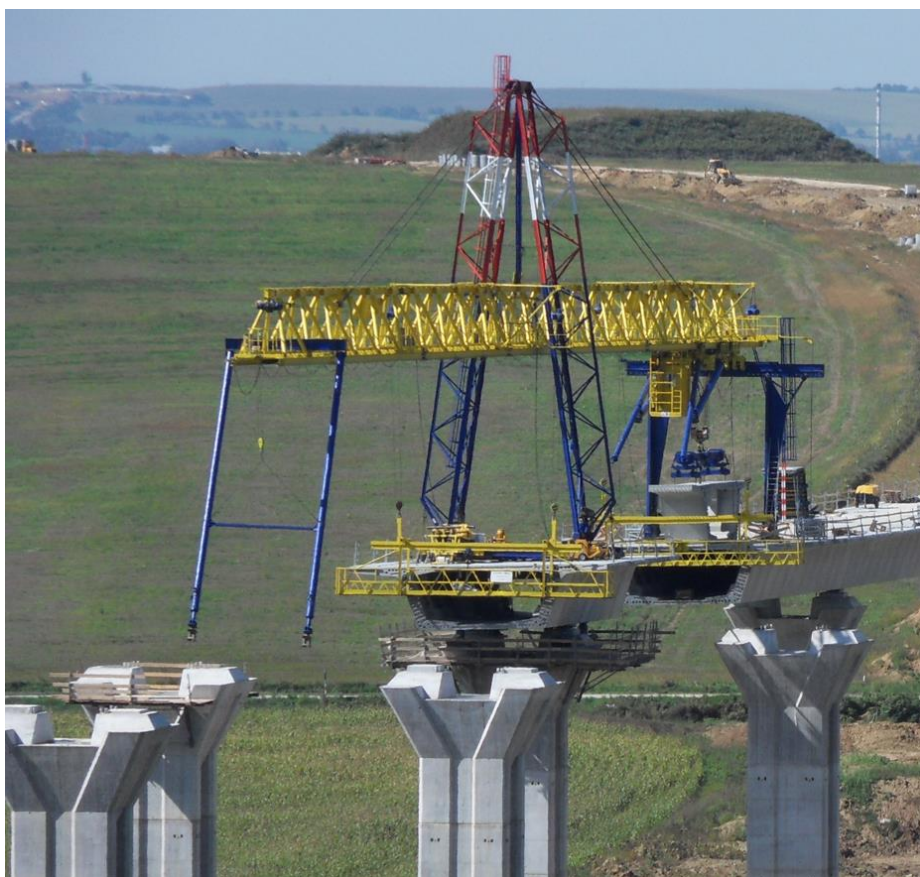
Obr. 73 Pohľad na MS (výstavba mosta pri Nitre, 2010, foto: Doprastav a.s.)
