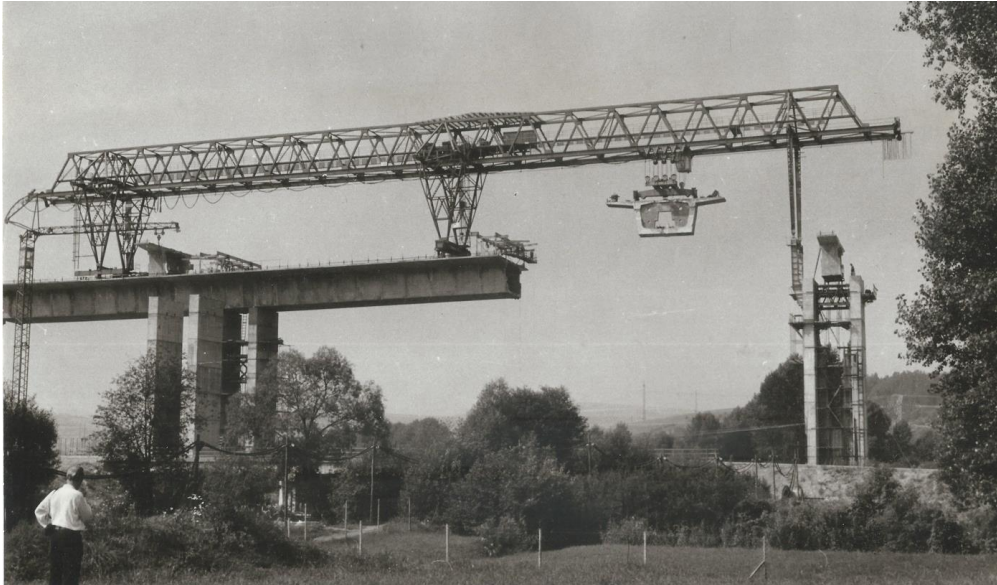
Obr. 107 Osadzovanie priečnikových segmentov.
