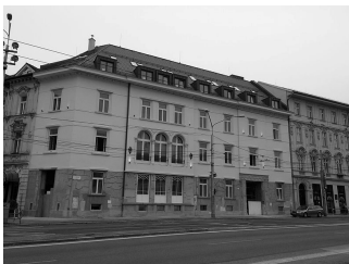
obr. 1 Uličný pohľad na objekt na Štefánikovej ul. č. 1
