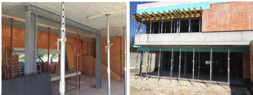
Obr. 2 Ocelový rám 1.NP
