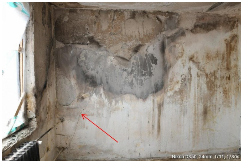
Obrázok 2: Šikmá trhlina v stene na 11. poschodí zo strany bytu č.48
