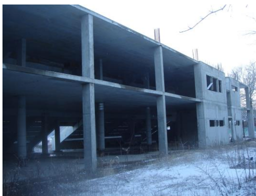
Obr. 2 Pohľad na časť rozostavanej tribúny (január 2018)
