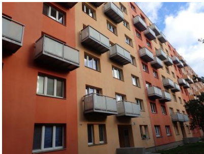
Obr. 1 Obytný dům se zavěšenými balkóny
