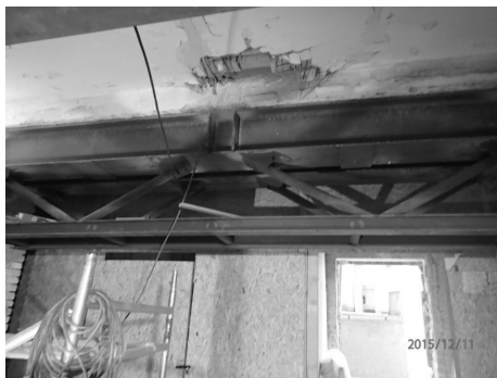
obr. 6 Zosilnenie ocel'ového valcovaného nosníka na priehradový nosník
