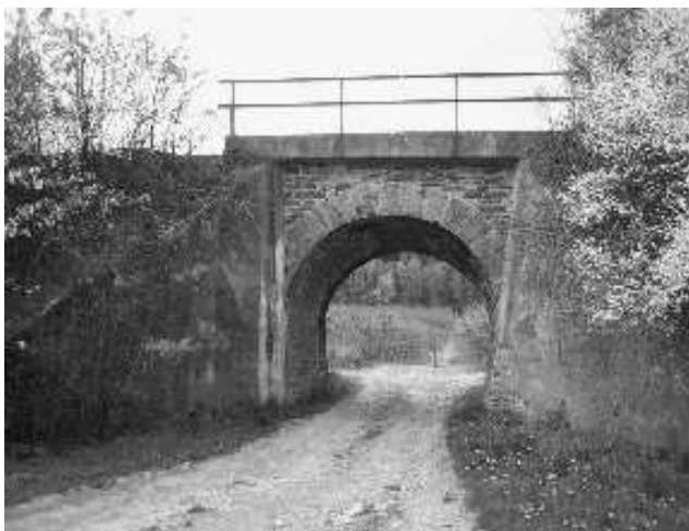
Obr.2 Klenba s nízkym nadnásypom (SO 12-19-15, km 22,586)
