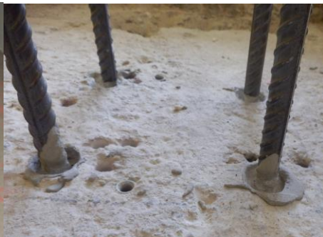
Obr. 2 Zalievanie kotviacich bodov
