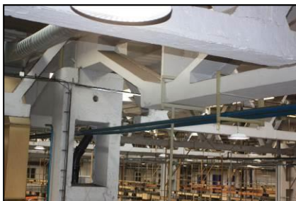
Obr. 5 Podvesenie technologických rozvodov na nosnú konštrukciu
