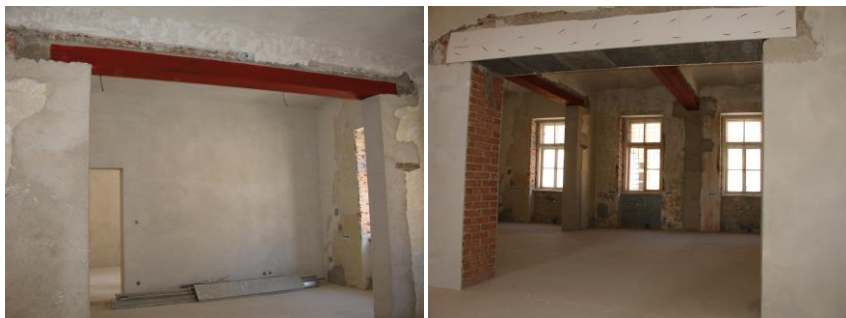
Obr. 3 Podchytávanie priečnych stien zvaranými valcovanými U profilmi
