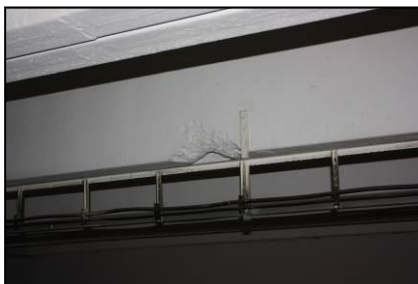
Obr. 4 Kotvenie technologických rozvodov do nosnej konštrukcie
