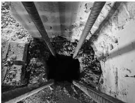
Obr. 4 Zosilňovanie murovaného stĺpa
