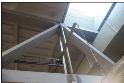
Obr. 5 Podvesenie technologických rozvodov na nosnú konštrukciu
