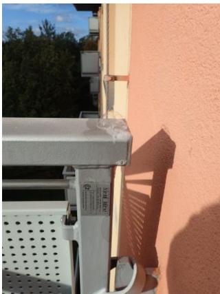
Obr. 8 Mýdlové bubliny na plastové zátce na straně „II“
