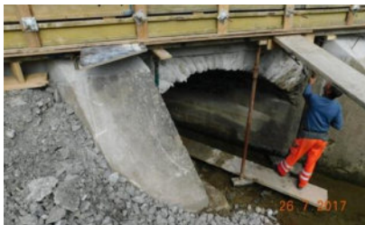
b) Kamenný most v Kline (rekonštrukcia)
