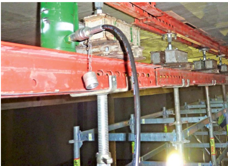
Obr. 3: Aktivované provizorní podepření stropních panelů
