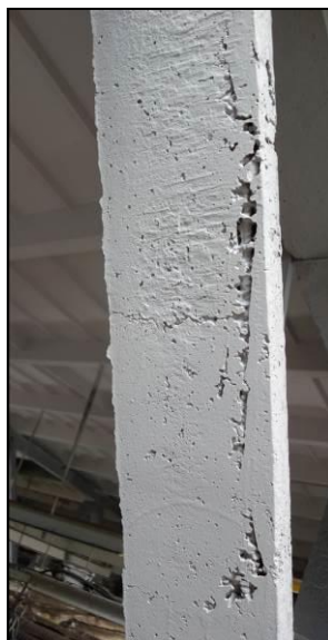
Obr. 6 Poruchy spôsobené počas betonáže a montovania nosných prvkov
