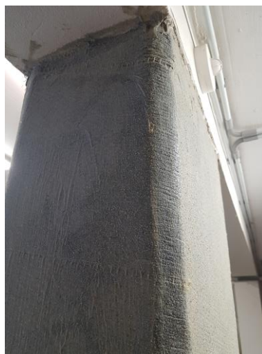
Obr. 6 Železobetónový stĺp po zosilnení
