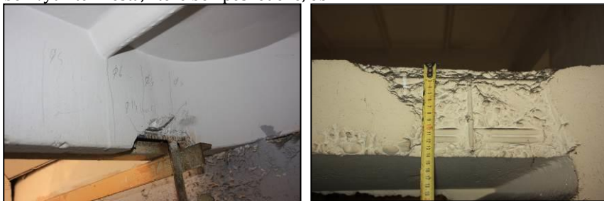
Obr. 2 Zisťovanie vystuženia vybraných nosných prvkov
