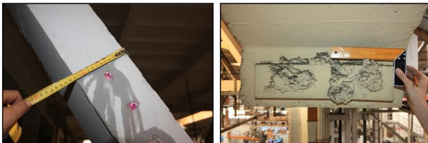
Obr. 1 Meranie skutočných rozmerov nosných prvkov
