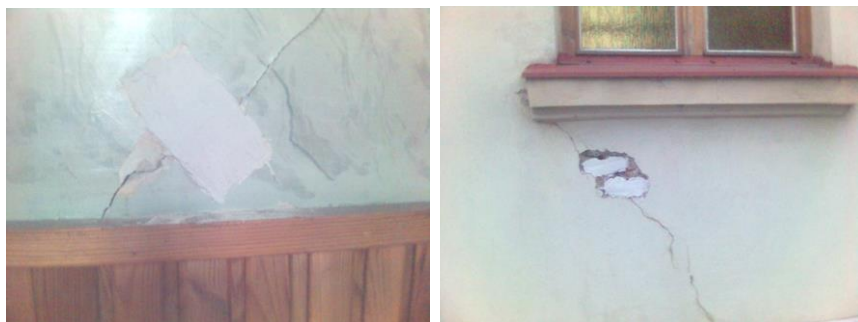
Obrázok 3 – Osadené sadrové terčičky: A – na vnútornej stene kostola, B – na vonkajšej stene kostola
