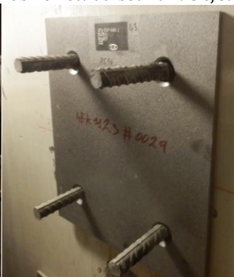
Obr. 6 Kotviaci bod na zvislej stene
