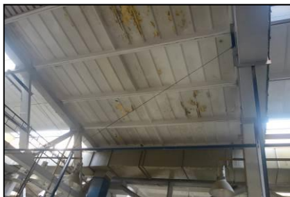
Obr. 3 Zatekanie nosnej konštrukcie
