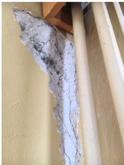
Obrázok 4: Rozdrvený betón v stene na 11. poschodí zo strany bytu č. 47
