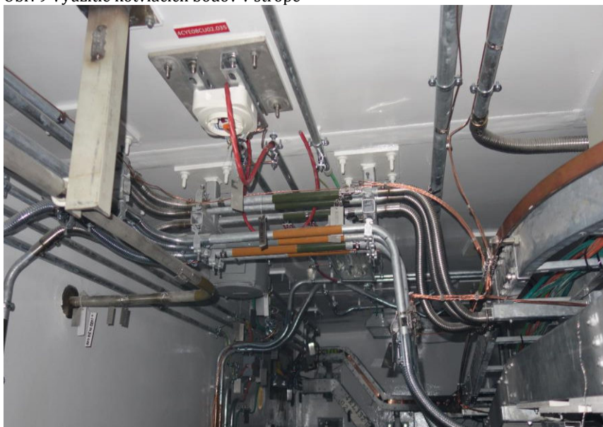
Obr. 9 Využitie kotviacich bodov v strope
