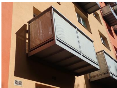
Obr. 2 Detail zavěšeného balkónu
