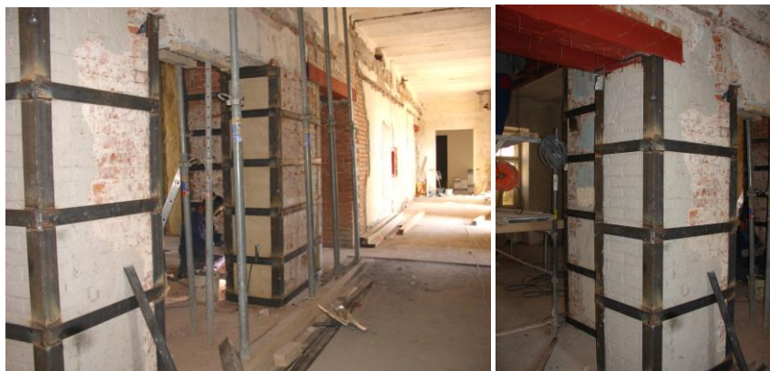
Obr. 4 Zosilnenie novovytvorených pilierov pomocou L profilov a pásikov
