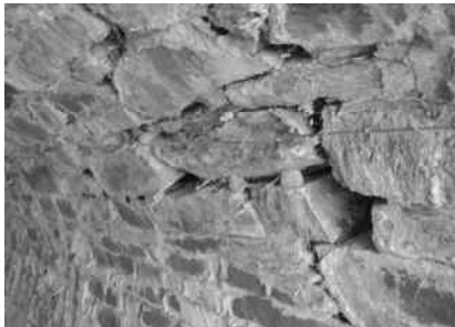
Obr.4 Vypadané škárovanie, medzery
