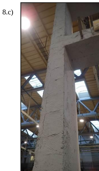
Obr. 8 Typické trhliny na nosnej konštrukcii
