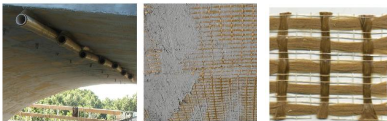
Obr. 6 Aplikácia PBO-FRCM na železničnom moste
