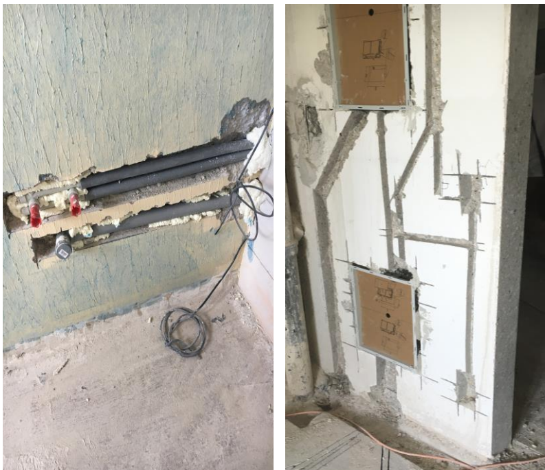
Obrázok 8: Znehodnotenie nosných stien vplyvom neodborných zásahov
