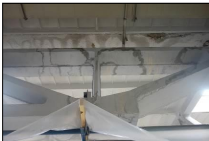
Obr. 3 Zatekanie nosnej konštrukcie
