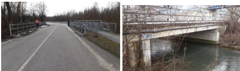
Obr. 1 Pohľad na mostný objekt
