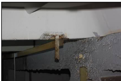
Obr. 4 Kotvenie technologických rozvodov do nosnej konštrukcie
