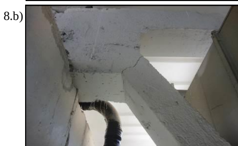
Obr. 8 Typické trhliny na nosnej konštrukcii
