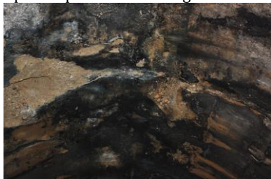
Obr. 5 Rozpad betónu ostenia
