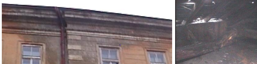
Obr. 2 Dokumentovanie havarijného stavu časti krovu
