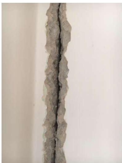
Obrázok 6: Odhalený styk stenových panelov na 12. poschodí
