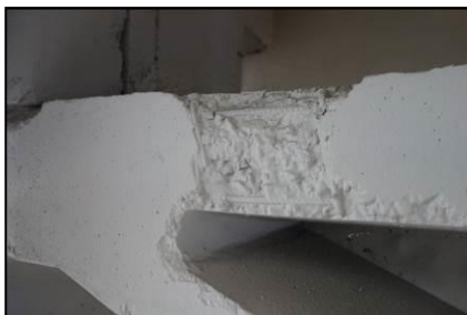
Obr. 6 Poruchy spôsobené počas betonáže a montovania nosných prvkov
