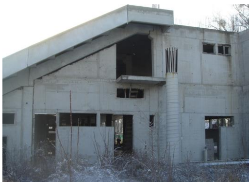
Obr. 3 Zlé statické rozmiestnenie otvorov v nosnej stene
