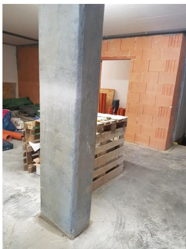
Obr. 6 Železobetónový stĺp po zosilnení
